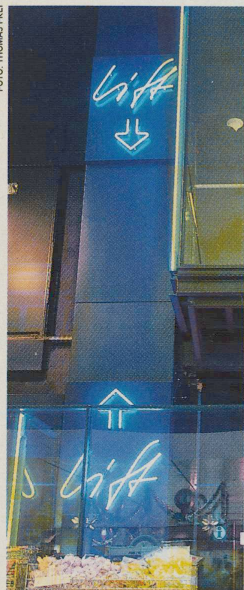
Lifte, aus dem Betonschacht befreit: Spielfeld für Designer. S. 64
