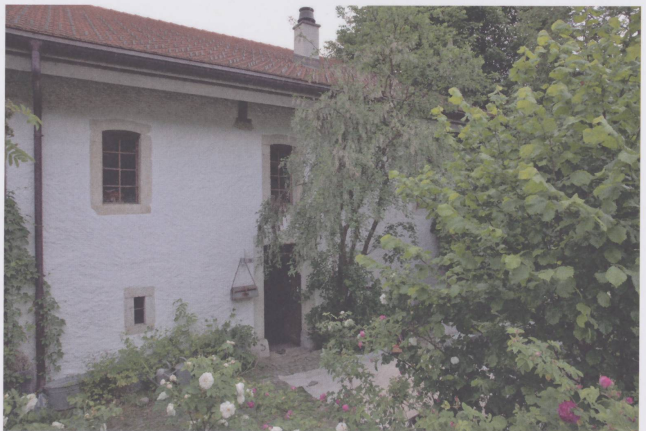
Figure 10 : La façade nord ne manque pas de charme. (Photo C. Choffat)
