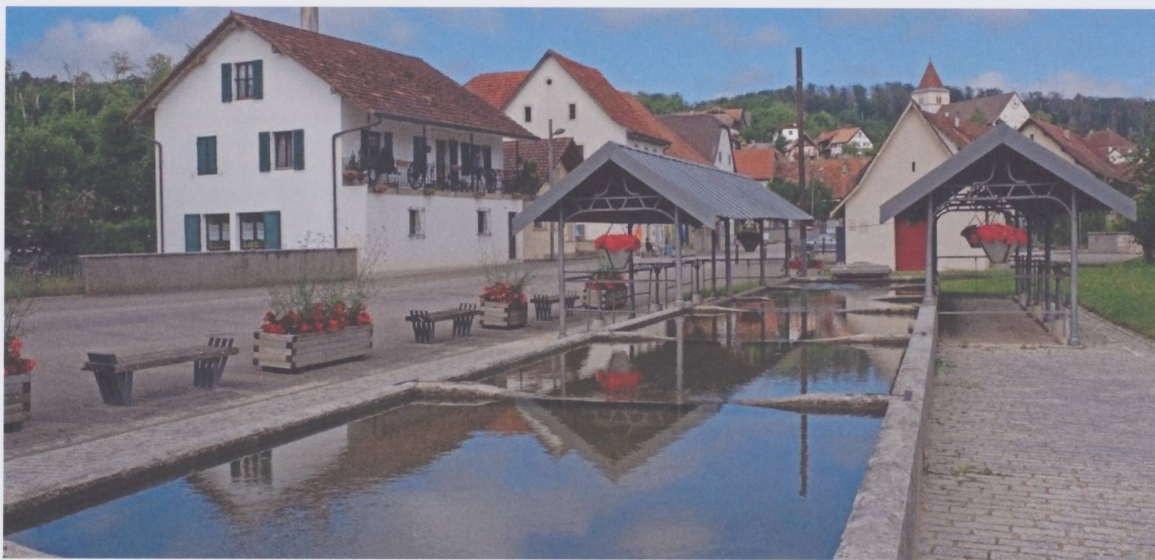
Figure 3 : Coeuve, Lavoir public alimenté par la source de la Coeuvatte. Installé au milieu du XVIII e siècle et transformé en 1894. Les bassins de lavage en pierre sont en partie abrités par des toits de tôle soutenus par des supports en fonte. Classé monument historique en 1973, il a été entièrement rénové en 1999. (Photo Jean-louis Merçay, 2021)
