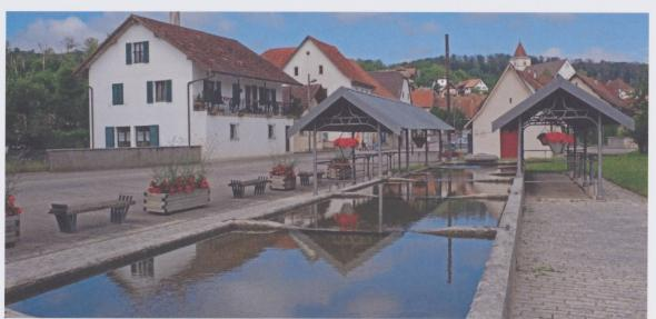
Figure 3 : Coeuve. Lavoir public alimenté par la source de la Coeuvatte. Installé au milieu du XVIII<sup>e</sup> siècle et transformé en 1894. Les bassins de lavage en pierre sont en partie abrités par des toits de tôle soutenus par des supports en fonte. Classé monument historique en 1973, il a été entièrement rénové en 1999. (Photo Jean-louis Merçay, 2021)
