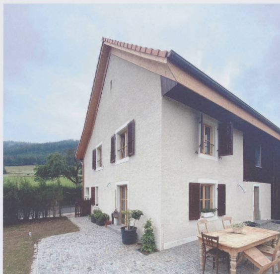
Figure 1 : Façade nord à pignon. Au sol, pose de pavés. (Photo Bureau Arches 2000 SA, 2021)
