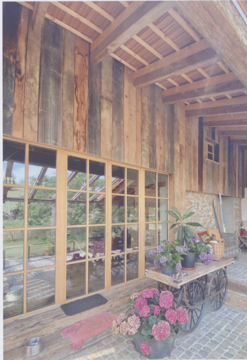
Figure 17 : Côté jardin, Arches 2000 SA a opté pour une baie à meneaux qui fait entrer la lumière et permet une vue panoramique sur le paysage. L'ancien bardage en bois a été reposé sur la nouvelle structure. La structure de la toiture de la terrasse a été conservée, seule la couverture en tuiles a été refaite à neuf. (Photo Bureau Arches 2000 SA, 2021)
