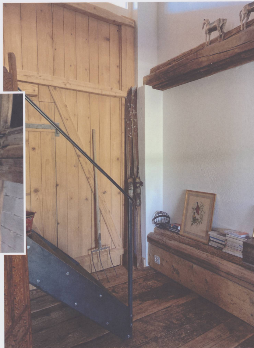
Figure 9 : Pose d'un escalier en acier brut dont les premières marches longent l'ancienne porte de la grange. Voici une jolie idée pour récupérer de l'espace : habillage du soubassement avec d'anciennes poutres récupérées. Le rustique et le moderne s'épousent avec charme tout comme le chaud du bois et le froid du métal. (Photos Bureau Arches 2000 SA, 2021)
