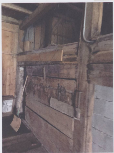
Figure 8 : Le pelle (réserve de pailles) avant transformation.
