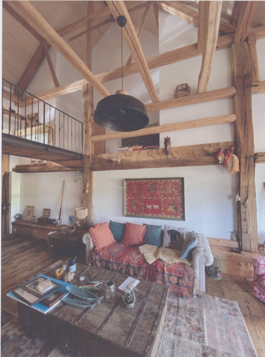
Figure 13 : En supprimant le plancher, création d'un volume aéré où la structure du bâti est mise en valeur de façon graphique. Sol et poutres se répondent harmonieusement. (Photo Bureau Arches 2000 SA, 2021)
