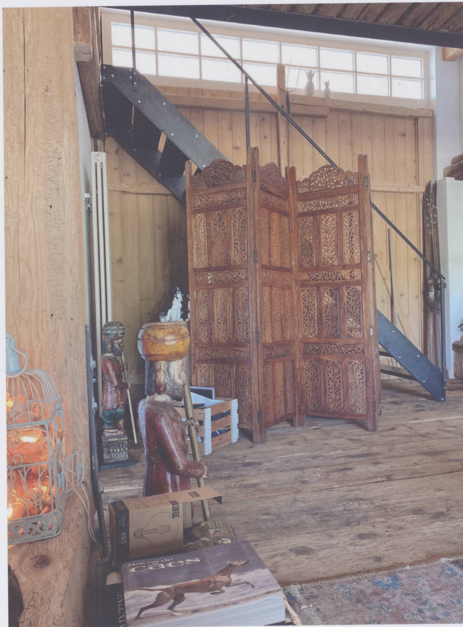
Figure 12 : La suppression d'un plancher a permis de percer une baie oblongue qui épouse la partie supérieure de la porte de la grange. Outre l'apport évident de lumière naturelle, la fenêtre à meneaux dessine un linteau transparent qui allège le côté massif de l'ancienne porte. (Photo Bureau Arches 2000 SA, 2021)
