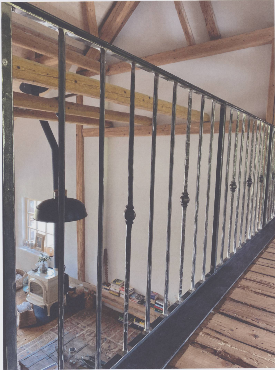
Figure 14 : Parti-pris contemporain et léger, une passerelle en bois permet d'accéder aux chambres. Son élégant garde-corps en fer forgé a été réalisé par un forgeron de la région : Marc Grélat. Le système de chauffage à pellet est complété par un petit poêle en fonte délicieusement vintage que l'on aperçoit au bas de l'image. (Photo Bureau Arches 2000 SA, 2021)
