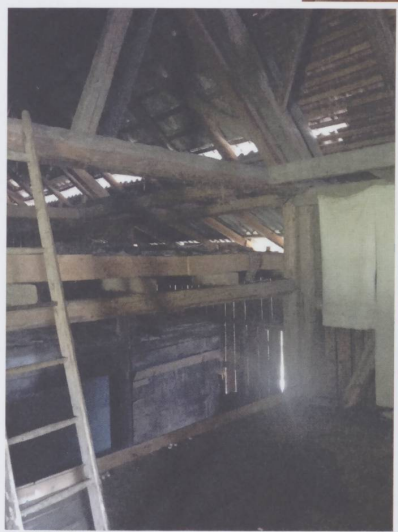
Figure 10 : Les combles et la toiture avant, du rural au moment de l'acquisition.
