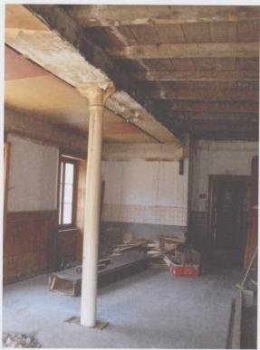
Figure 3 : découverte d'un poteau métallique (F. Rosset, 2014)
