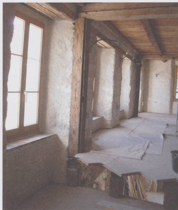
Figure 6 : pose d'enduits à la chaux (F. Rosset, 20164441)
