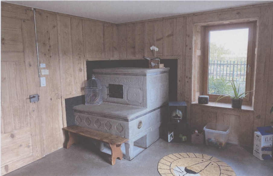
Figure 9 : le fourneau à banc (N. Schnegg, 2020)
