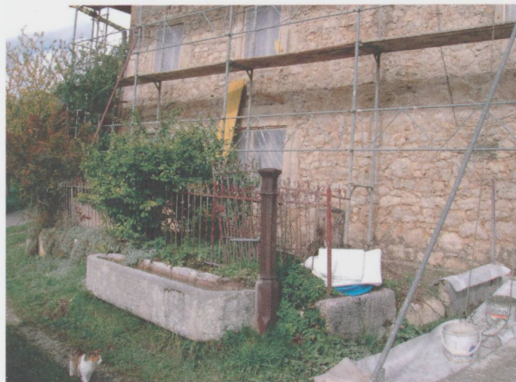
Figure 5 : fontaine et façade sud après enlèvement de l'ancien crépi. (Pierre-Alain Girard, 2017).
