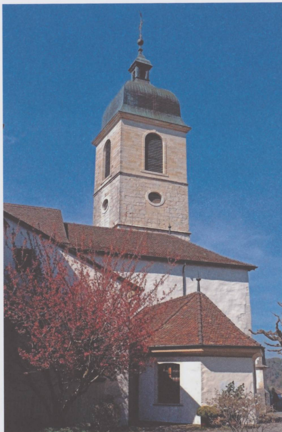
Figure 6 : État actuel du clocher de l'église Saint-Pierre à Porrentruy, vu du sud-ouest. On remarque la différence des appareils de pierre entre l'étage ancien, dans lequel des œils-de-bœuf ont été percés en 1776, et l'étage supérieur, construit à cette date. Jusqu'en 1965, le dôme de type comtois était couvert de tuiles vernissées (photo Jean-Louis Merçay, 2018).
