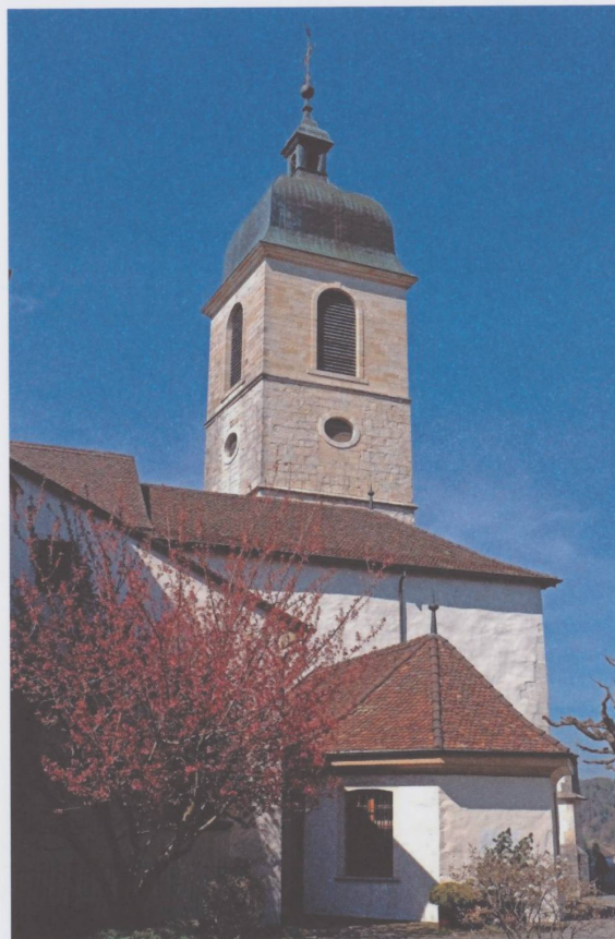
Figure 6 : État actuel du clocher de l'église Saint-Pierre à Porrentruy, vu du sud-ouest. On remarque la différence des appareils de pierre entre l'étage ancien, dans lequel des œils-de-bœuf ont été percés en 1776, et l'étage supérieur, construit à cette date. Jusqu'en 1965, le dôme de type comtois était couvert de tuiles vernissées (photo Jean-Louis Merçay, 2018).
