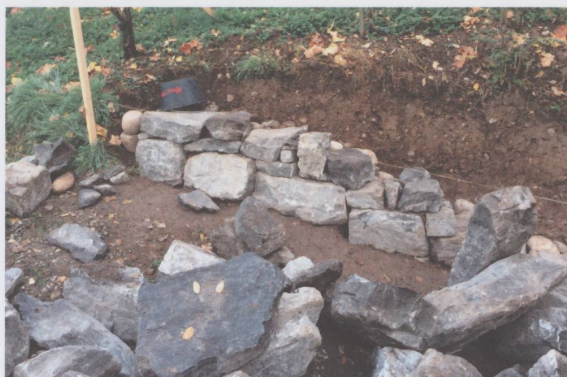
Figure 11 : Mur de soutènement. La technique est la même pour les murs libres (murs de pâturages) et les murs de soutènement. On s'adapte aux pierres tout en respectant les règles de construction pour chaque pierre, de la plus petite à la plus grande. Avec la pierre sèche, on peut faire toutes sortes de formes, chaque type de pierres donne un cachet particulier au mur fini. (Oberhoffen, octobre 2017, mur de soutènement dans les vignes, pour la préservation de l'habitat de la couleuvre tisse, photo Moussia de Watteville)
