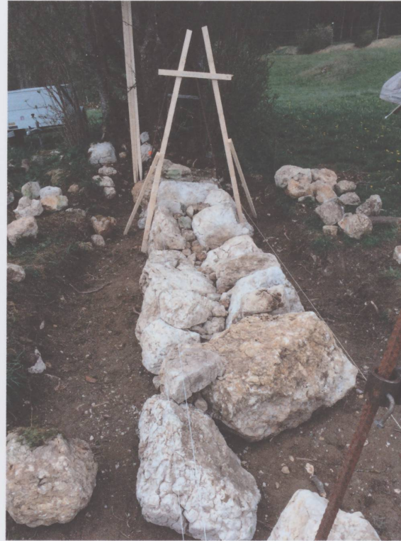
Figure 5 : Après s'être occupé des faces du mur, on remplit l'intérieur du mur, d'abord avec les plus grosses pierres possible, puis avec du plus petit matériel. (Malleray, été 2017, photo Moussia de Watteville)
