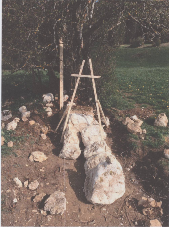
Figure 4 : Les pierres de fondation sont posées, elles sont grosses et lourdes. Elles suivent ou s'appuient sur le fil tendu entre les gabarits en bois. On pose d'abord les pierres de manière à ce qu'elles forment une face du mur, un côté puis l'autre, le plus possible en parallèle. Le gabarit est en forme de « A », cette forme donnera une inclinaison au mur, on appelle cela le fruit du mur, c'est-à-dire que plus le mur monte, plus il devient étroit, la le rend plus stable. (Malleray, été 2017, photo Moussia de Watteville)
