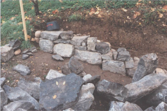
Figure 11 : Mur de soutènement. La technique est la même pour les murs libres (murs de pâturages) et les murs de soutènement. On s'adapte aux pierres tout en respectant les règles de construction pour chaque pierre, de la plus petite à la plus grande. Avec la pierre sèche, on peut faire toutes sortes de formes, chaque type de pierres donne un cachet particulier au mur fini. (Oberhoffen, octobre 2017, mur de soutènement dans les vignes, pour la préservation de l'habitat de la couleuvre lisse, photo Moussia de Watteville)
