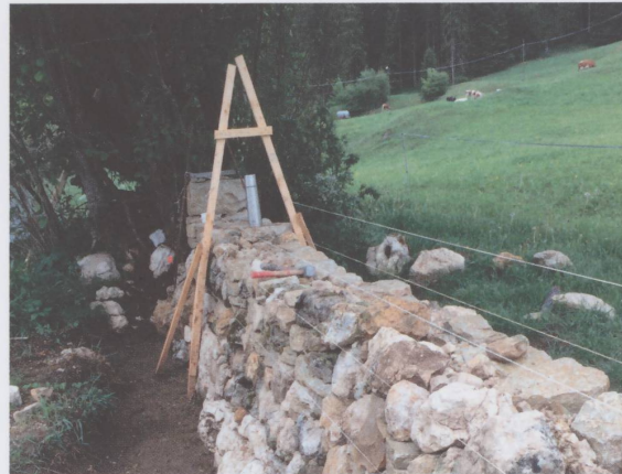
Figure 9 : La dernière couche est préparée pour accueillir ensuite les couvertines. On voit ici les fils qui servent à respecter le fruit du mur ainsi que sa hauteur. Ils gênent souvent, mais ils sont indispensables. (Malleray, été 2017, photo MdW)
