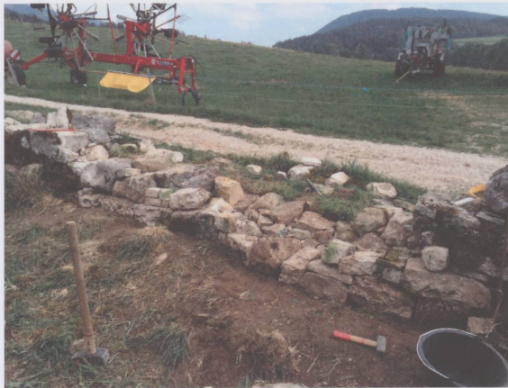
Figure 6 : Les pierres de construction sont posées sur les pierres de fondation, il n'y a plus d'espace, aucune pierre ne bouge. (Nods, septembre 2016, photo Moussia de Watteville)
