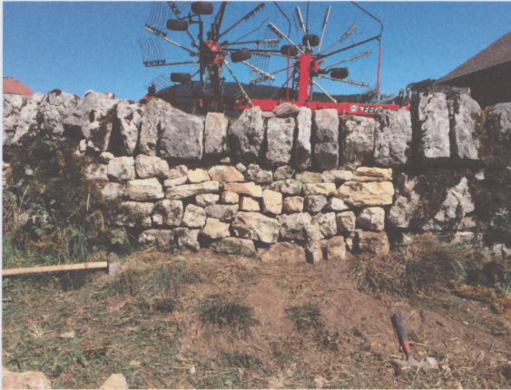
Figure 10 : Réparation d'un mur terminée. (Nods, septembre 2016, photo MdW)
