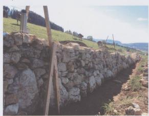
Figure 8 : Le gabarit pourra bientôt être enlevé, le mur a presque atteint la hauteur désirée. (Malleray, été 2017, photo Moussia de Watteville)
