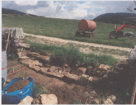
Figure 3 : Pierres de fondation. Tout a été posé à la main. (Nods, septembre 2016, photo Moussia de Watteville).
