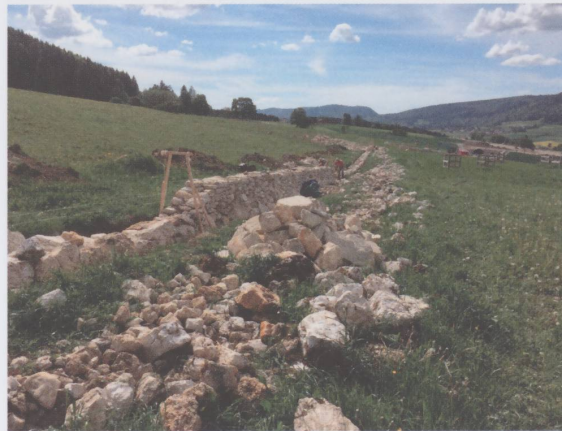
Figure 7 : Les muretiers travaillent en principe chacun de leur côté. Le mur monte en même temps de chaque côté. On s'aide, on se parle, on s'arrange pour placer ensemble des pierres « traversantes », celles qui traversent le mur de part en part. (Malleray, été 2017, photo Moussia de Watteville)
