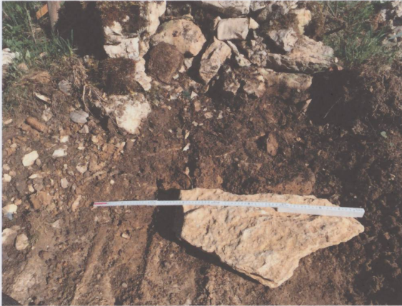
Figure 2 : Les machines ont démonté le mur et préparé grossièrement la base, le terrain est reconditionné de manière plus précise à la main, en sorte d'une largeur adaptée à la moitié de la hauteur. Les pierres de fondation sont choisies. (Mont-Crosin, été 2016, photo Moussia de Watteville)
