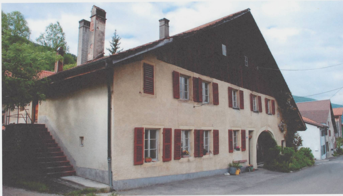
Figure 6 Le nid des Robert, de nos jours. Détail. La vigne vierge cache presque entièrement l'angle sud-est. Par rapport à 1928, hormis que les volets étaient remplacés par les fenêtres doubles courantes dans la saison froide, la fenêtre du rez à gauche a été élargie, la petite porte au rez à droite a été remplacée par une fenêtre (c'était probablement l'entrée de l'écurie à l'époque) et quelques petites ouvertures dans la partie boisée supérieure (comme la forme en cœur) semblent postérieures. Ce qui a changé, c'est ce qui se trouve devant la ferme, de l'autre côté de la route. Le mur visible à gauche est toujours là mais complètement caché par une grande haie. Les deux piliers de pierre ont disparu et la configuration du terrain a été modifiée. L'adresse actuelle est Vieille-Route 10 (à env. 100m à l'ouest de la salle polyvalente). La propriétaire actuelle est Françoise Beeler. (Photo Isabelle Roland, légende : Jean Vaucher)
