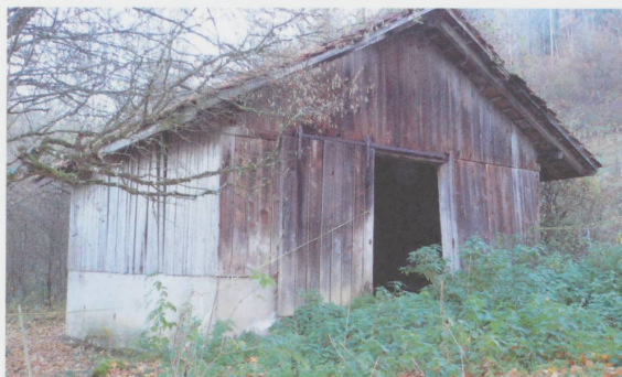
Figure 5 7-01 Belfond, le montant droit est déboîté de la sablière, c'est de mauvais augure ! (Photo N. Gogniat, 2015)
