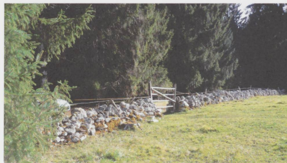
Figure 33 2-04 Les pâturages sont clôturés par de vieux murs en pierres sèches avec des pieux posés en chevalet en alternance. (Photo N. Gogniat, 2015)
