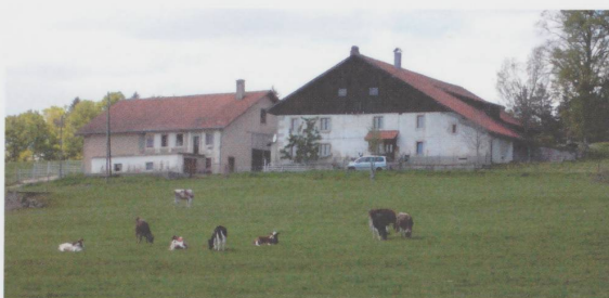
Figure 23 2-05 Les Fonges, cette bergerie est la propriété de la commune de Muriaux sur le bien-fonds des Bois. (Photo N. Gogniat, 2015)
