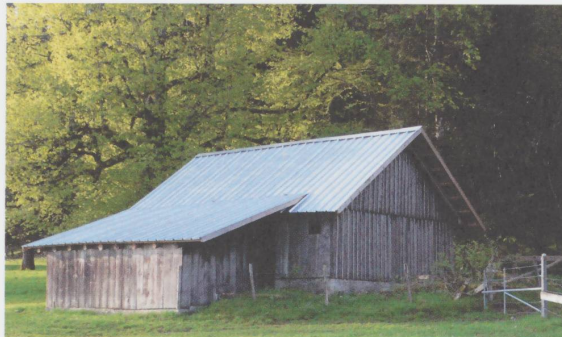
Figure 6 8-01 Les Crâs, nouvelle couverture en tôle. (Photo N. Gogniat, 2015)
