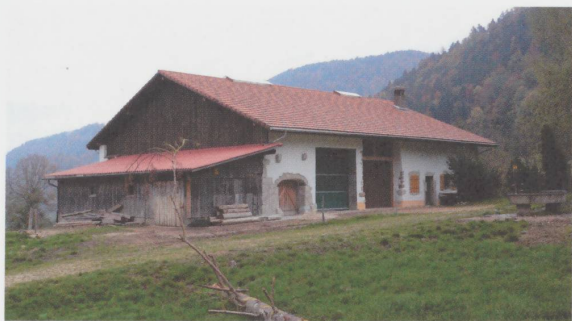
Figure 20 17-06 La ferme du Cràs toute rénovée, avec un modeste espace au nord pour abriter le bétail. L'appartement est habité. (Photo N. Gogniat, 2015)
