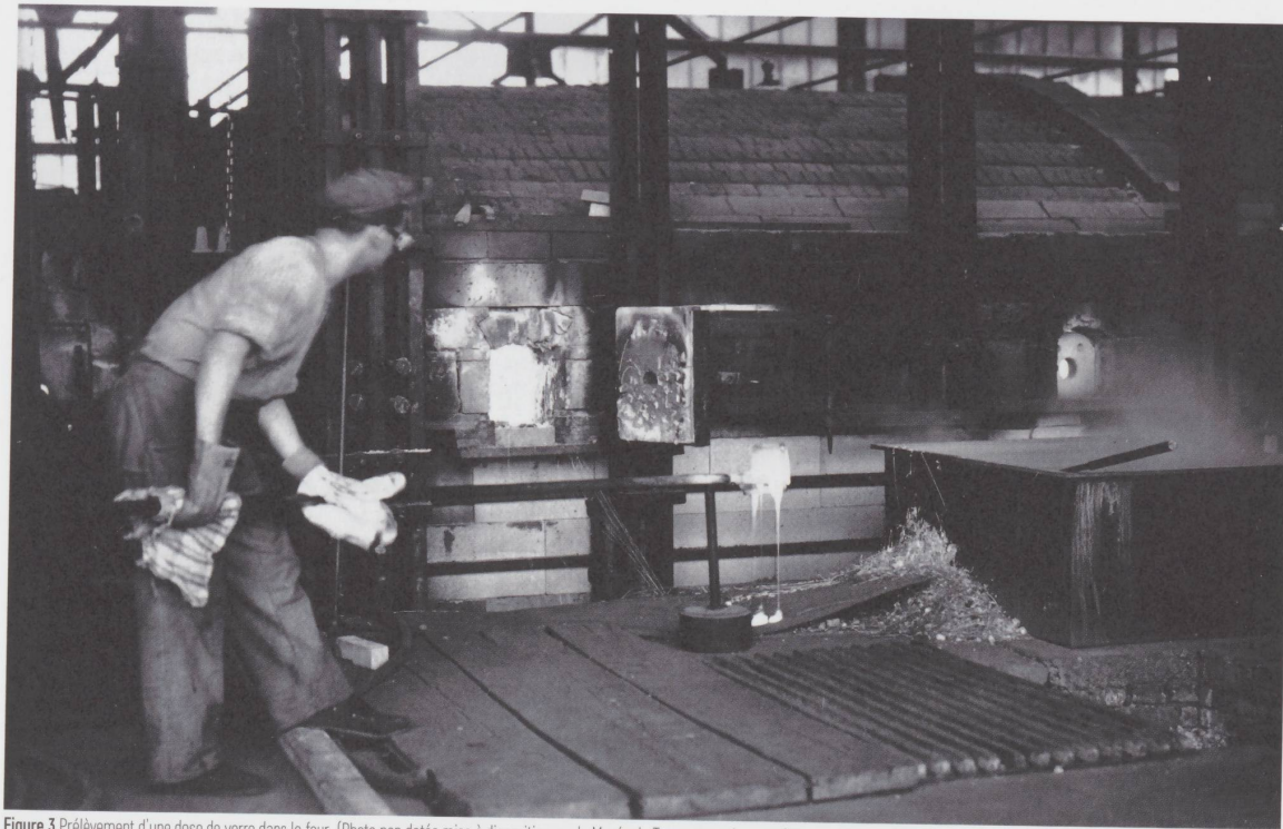
Figure 3 Prélèvement d'une dose de verre dans le four. (Photo non datée mise à disposition par le Musée du Tour automatique et d'Histoire à Moutier)
