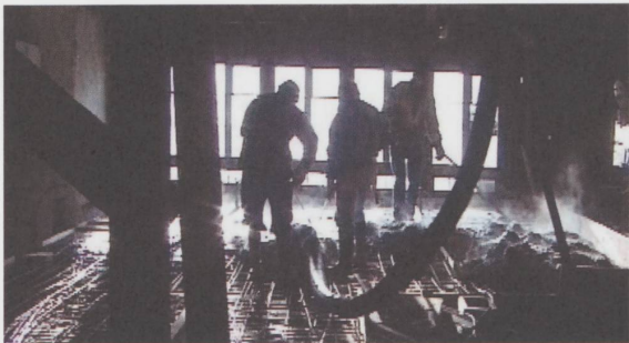
Figure 12 Coulage du béton. (Photographie extraite du film)
