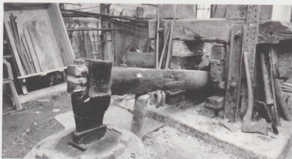
Figure 16 L'intérieur de la forge avec le tronc d'arbre qui fait office de bras de transmission pour le martinet. Un martinet qui porte la date de 1791. (Photographie extraite du film)
