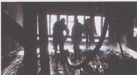
Figure 12 Coulage du béton. (Photographie extraite du film)
