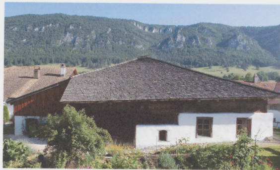
Figure 11 Façade sud. La toiture (à quatre pans) a bénéficié d'une nouvelle toiture recouverte de bardeaux. (Photographie extraite du film)
