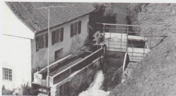
Figure 17 La Forge avec vue sur la roue à aubes actionnée par la rivière, la Gabiatte (ou Gaibat, selon les sources). (Photographie extraite du film)
