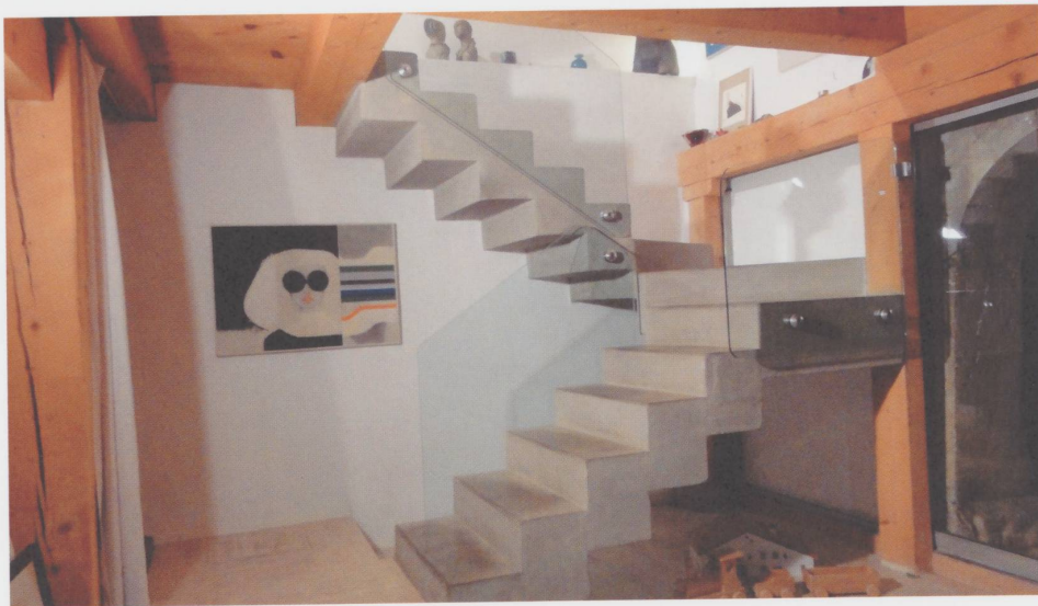
Figure 14 Le nouvel escalier en béton et verre, qui a pris exactement la place de l'ancien, devenu impraticable.
