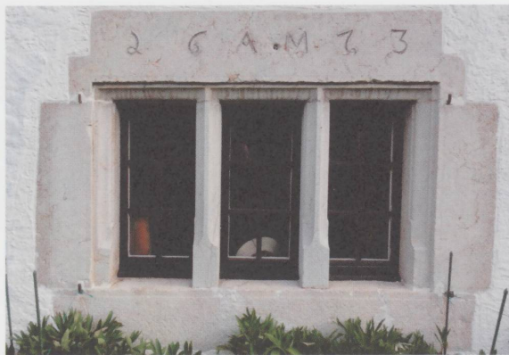
Figure 4 Fenêtre au linteau (1673) et ses deux nouveaux meneaux. (Photographie H. Schneider, 2017)
