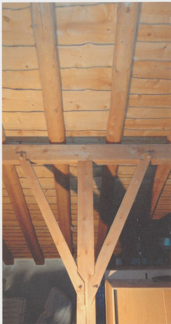
Figure 3 Charpente, chevrons taillés sur deux faces, poutres assemblées par chevilles de bois. (Photographie H. Schneider, 2017)
