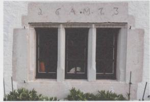
Figure 4 Fenêtre au linteau (1673) et ses deux nouveaux meneaux. (Photographie H. Schneider, 2017)
