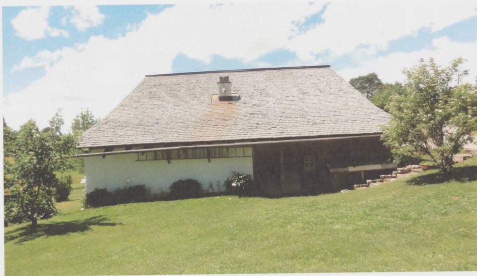
Figure 10 La façade orientale et son auvent fermé par une ramée. À l'origine, des sureaux étaient plantés aux quatre coins de la ferme. Seuls trois subsistaient à notre arrivée. Selon les anciens, il s'agissait de protéger la ferme de la foudre. Nous les avons remplacés.
