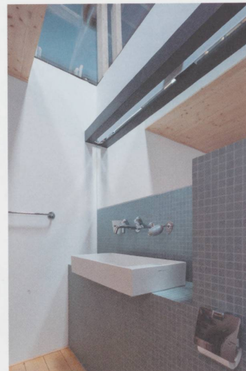
Figure 20 Une salle de bain et une chambre ont été construites au premier étage. La baie vitrée éclairant l'évier reçoit sa lumière directement des ouvertures pratiquées dans le toit. (Photographie d'Adrien Barakat, détail, 2017)
