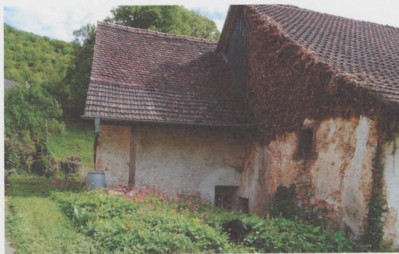
Figure 16 Le Nord-Est de la ferme avant rénovation. (Photographie Thierry Boillat, 2013)
