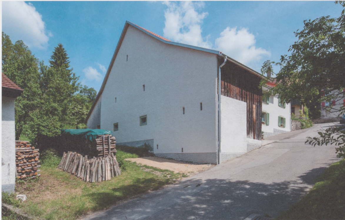
Figure 4 La façade à pignon après rénovation. La façade épurée et blanchie est à présent soulignée par un soubassement en crépi ciment peint en gris. (Photographie d'Adrien Barakat, 2017)
