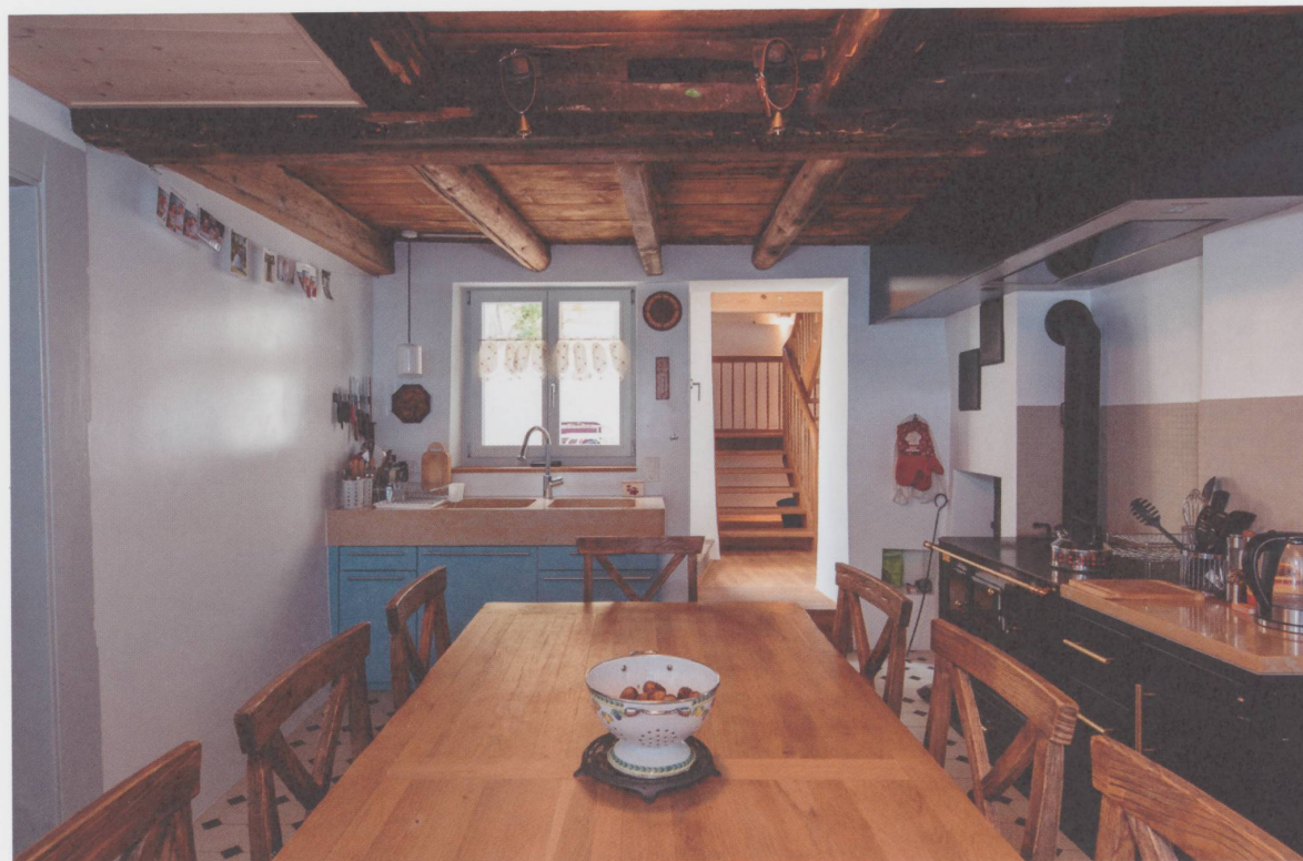
Figure 9 La cuisine après rénovation : les faux-plafonds ont été enlevés pour laisser apparaître planches et poutres noircies par la fumée. En revanche, le plancher de la cuisine n'a pas pu être conservé car en trop mauvais état. Il a été remplacé par un nouveau carrelage en grès. (Photographie d'Adrien Barakat, 2017)
