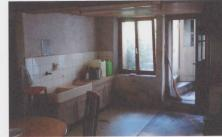
Figure 8 État de la cuisine avant rénovation. Au-dessus de l'évier on aperçoit l'unique robinet d'eau froide. (Photographie Thierry Boillat, 2013)
