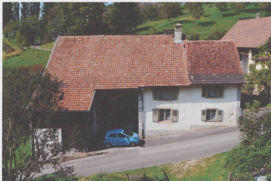
Figure 1 La ferme avant rénovation, façade principale, s'ouvrant sur rue pentue. (Photographie Thierry Boillat, 2013)
