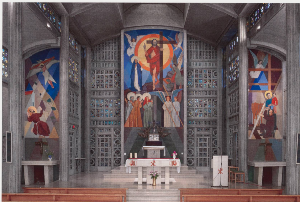
Chapelle de Montcroix, Delémont, 1950-51. Ossature et claustra de béton, inspirés de la Chapelle Sainte-Thérèse de Montmagny (Val d'Oise) par Auguste Perret (1874-1954). Vue du chœur. Photo Jacques Bélat.
