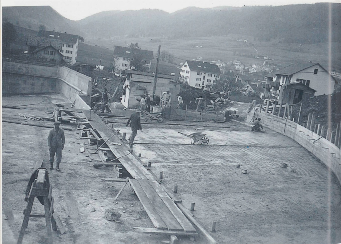
Figure 4 : Le chantier de la piscine vers 1948: à gauche, le bassin de 50 x 25 mètres et à droite une partie arrondie moins profonde qui permet l'apprentissage de la natation. Au milieu, la préparation des piliers de la barrière de séparation. On aperçoit à l'arrière-plan les quelques maisons du quartier. (Photo Pierre Froidevaux, actuellement propriété du Musée du tour automatique et d'histoire à Moutier.)
