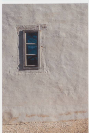
Figure 10 Mise en valeur des murs en moellon recouverts d'enduit à la chaux et préservation des encadrements de fenêtres. Celles-ci ont gardé leur encadrement d'origine, soit en pierre de taille à linteau droit (comme sur cette photo), soit en bois à linteau délardé. (Photo Luc Bron, 2013.)
