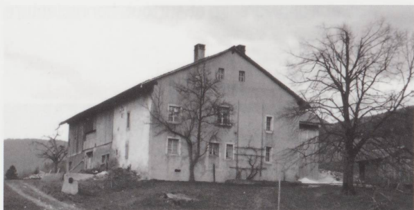
Figure 1 Façade ouest dans les années 1950, photographie (collection Roger Wisard, Grandval).
