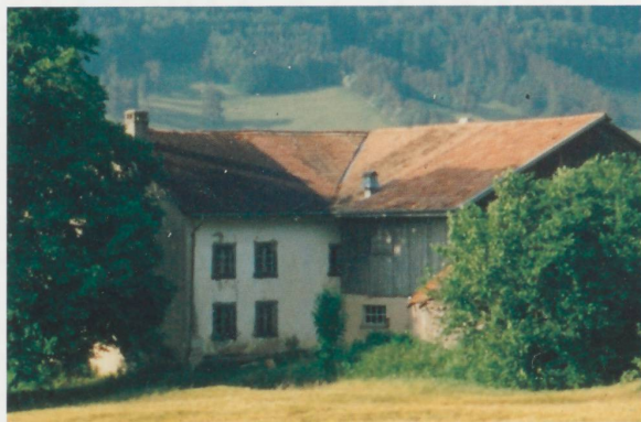
Figure 5 Même angle de vue de la ferme, mais cette fois nous sommes en 1995. (Photographie de 1995, collection Fabien Charmillot). « Malgré quelques transformations, note le rapport du Recensement architectural du Canton de Berne, cette ferme qui est aujourd'hui une habitation garde de belles proportions et une belle allure générale. »
