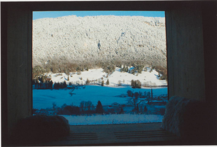
Figure 12 La fenêtre – vitrage affleurant à la façade et sans encadrement – favorise l'aménagement d'une niche dans l'épaisseur du mur et offre une vue magnifique sur le village de Grandval et le Raireux. (Photo Luc Bron, 2013.)
