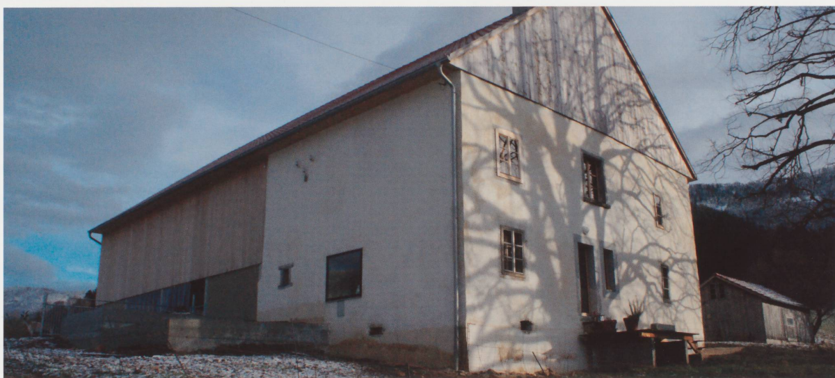
Figure 6 En façade nord, l'architecte ose une intervention contemporaine mais discrète sous forme d'un vitrage affleurant à la façade et sans encadrement. Le choix des matériaux s'est porté sur la chaux et le bois. (Photo Luc Bron, 2013.)
