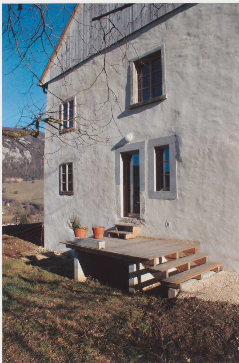
Figure 9 Façade ouest. Une fenêtre horizontale ouverte dans les années 1950 a été supprimée et la porte et la fenêtre qu'elle masquait ont été remises au jour. Celles-ci donnent sur la cuisine qui occupe une position centrale au rez-de-chaussée. Les autres fenêtres ont été refaites à l'ancienne. Toutes les façades extérieures sont enduites à la chaux. (Photo Luc Bron, 2013.)
