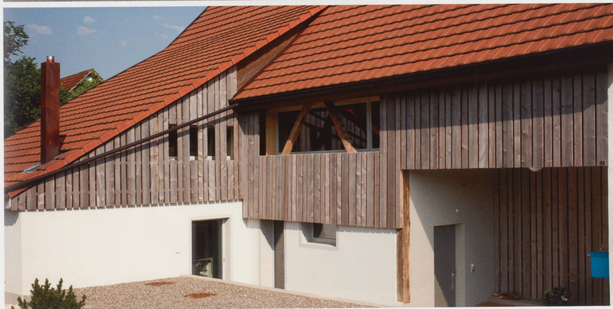
Figure 9: Façade nord, le lambrissage recouvre l'enveloppe de la maison. La porte d'entrée donne sur le devant-huis nouvellement créé. Photo Jacques Bélat.
