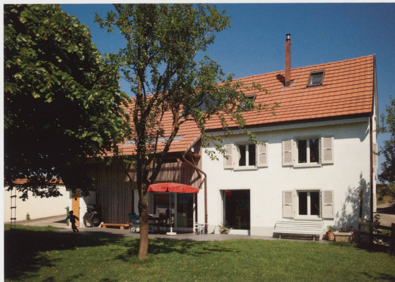
Figure 2: Façade sud, ouverture de deux baies vitrées au rez-de-chaussée. Les fenêtres d'origine ont été refaites en bois par des artisans locaux. Photo Jacques Bélat.
