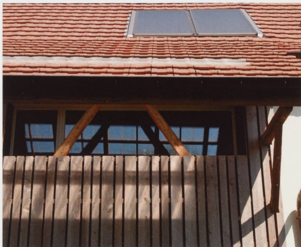
Figure 5 et 6: Premier étage, ouverture dans le lambrissage permettant l'éclairage de la chambre. Photos Jacques Bélat.
