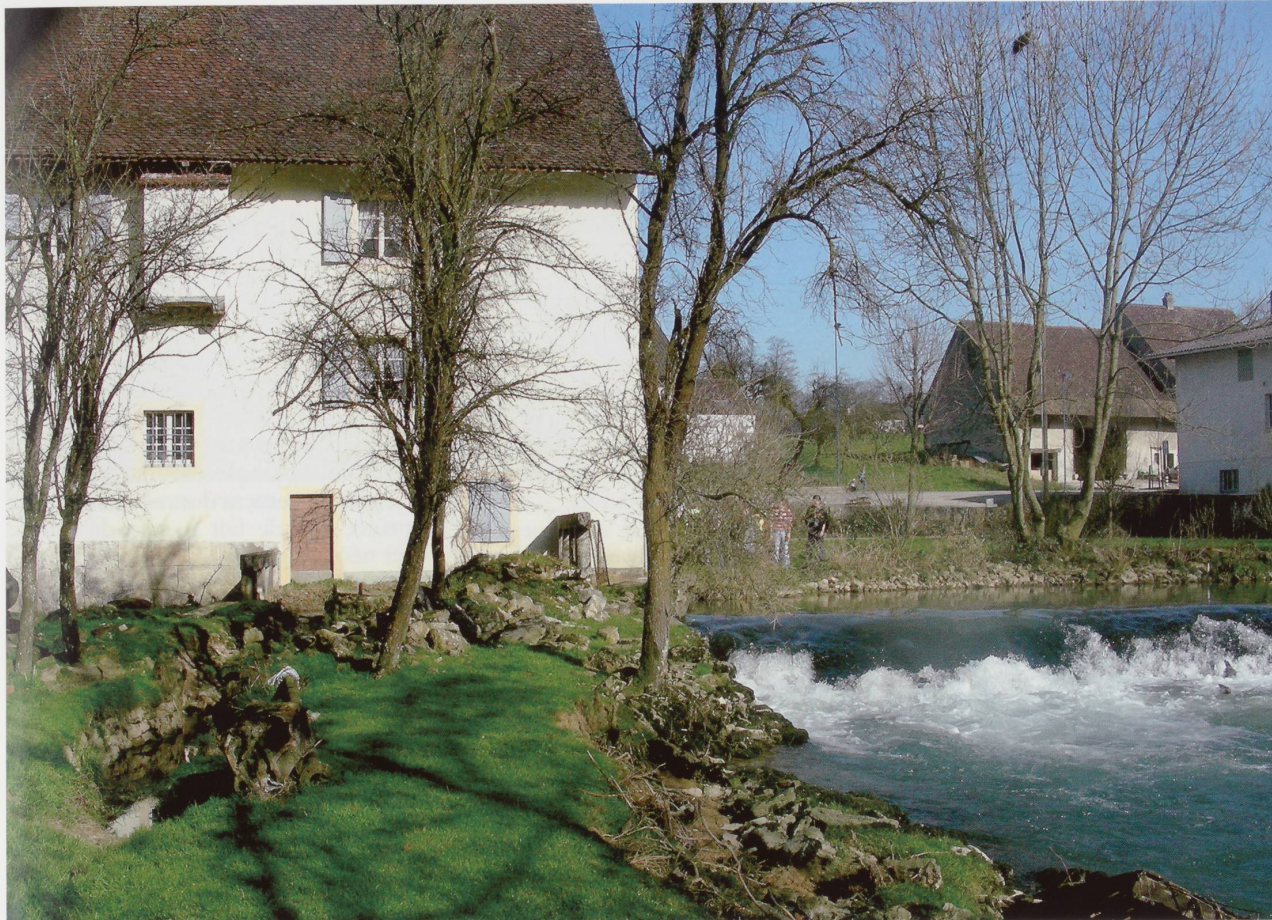
Figure 1. Vue ouest du moulin de Buix, avec l'écluse, 1993. Photographie OCJ (Office jurassien de la culture).
