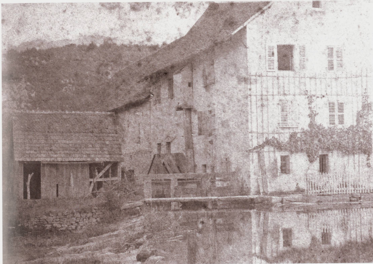
Figure 7. Roue de la mécanique (premier plan) et roue couverte pour les meules (arrière-plan), 1892. Auteur inconnu. Photographie retravaillée par Géraud Siegenthaler. Fonds Laurent, Buix.
