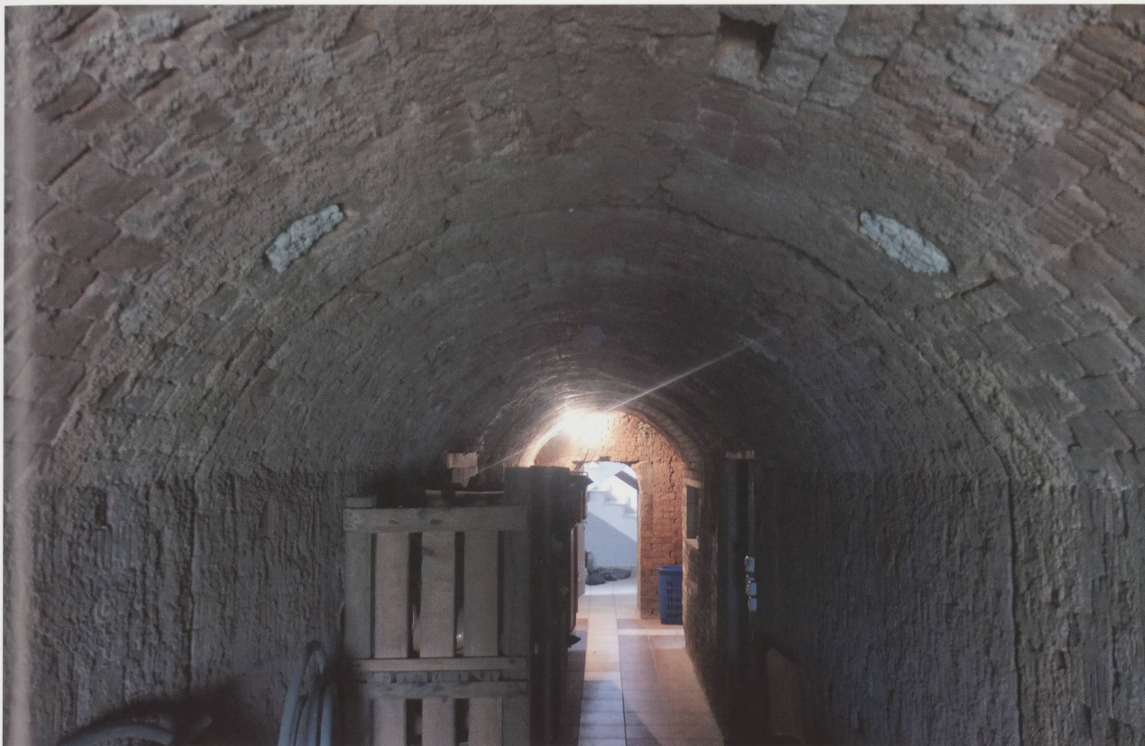
Figure 11 : l'un des jambages du four, actuellement au sous-sol de la maison Loviat. On remarque dans la voûte deux trous (aujourd'hui bétonnés et bien visibles) permettant d'alimenter le feu. Photo Jean-Louis Merçay.
