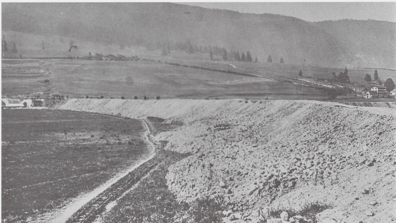
Construction de la ligne de chemin de fer Tavannes-Sonceboz, ici la grande courbe près de Corgémont. Photo de la collection de René Rimaz, Sonceboz.
