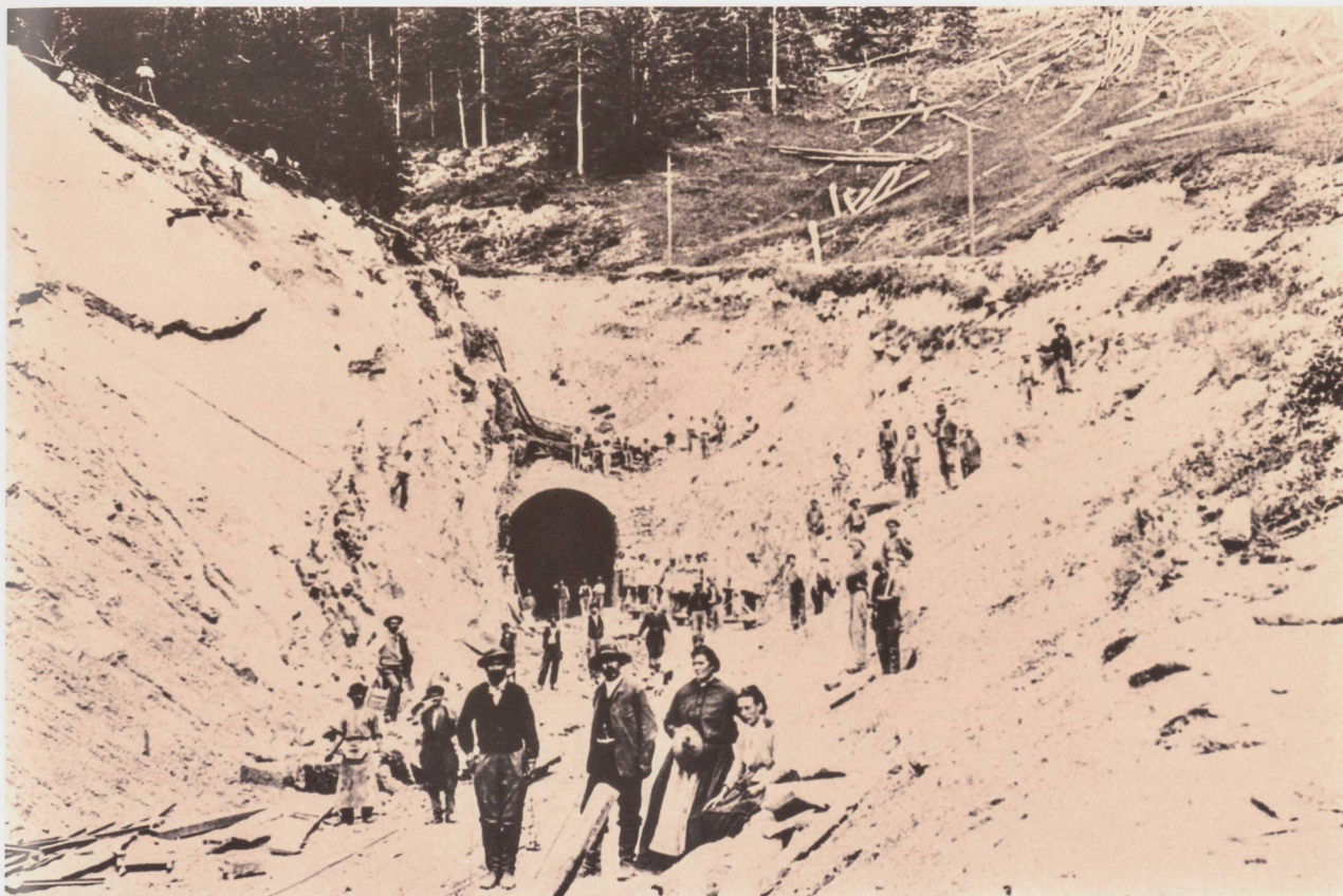
Percement du tunnel sous le Pierre-Pertuis pour la ligne de chemin de fer Tavannes-Sonceboz. Photo de la collection de René Rimaz, Sonceboz.
