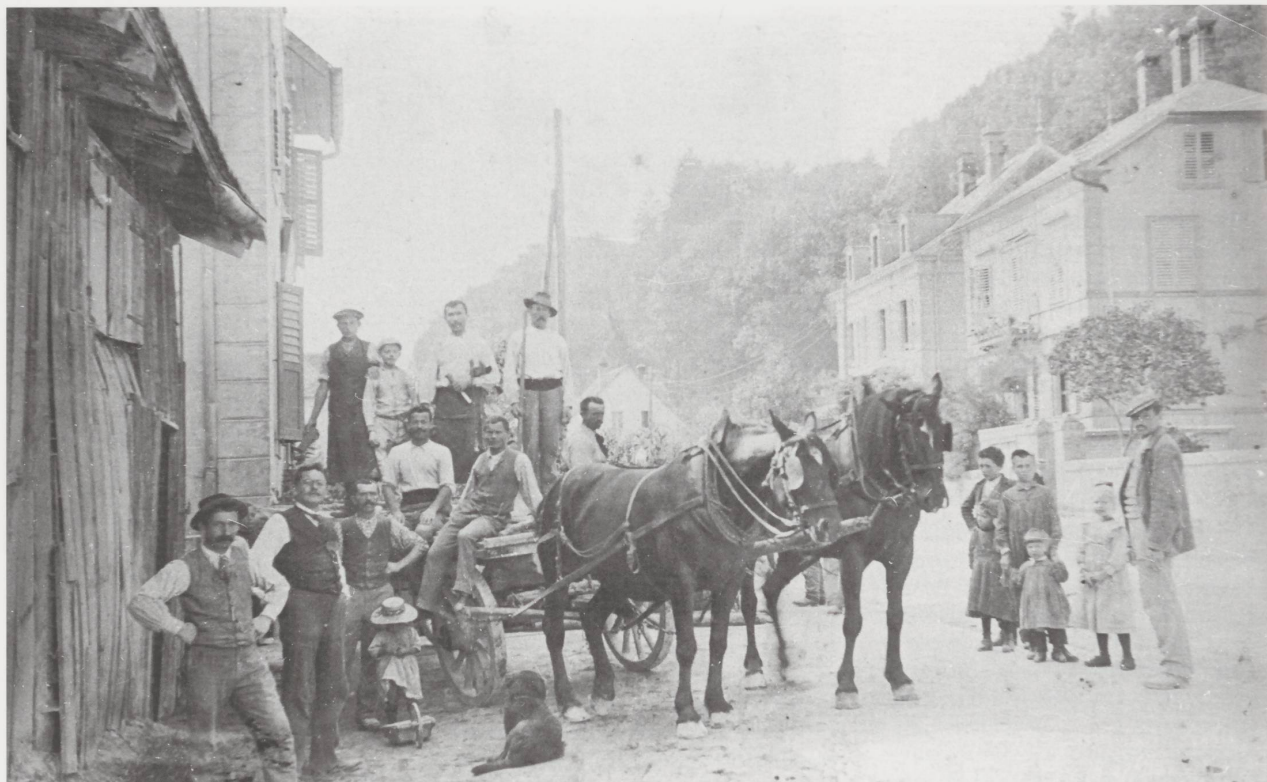
Porrentruy, ouvriers de l'entreprise Parietti, 26 août 1945. Photo: coll. Musée de l'Hôtel-Dieu – Porrentruy (MHDP), fonds Albert Perronne.
