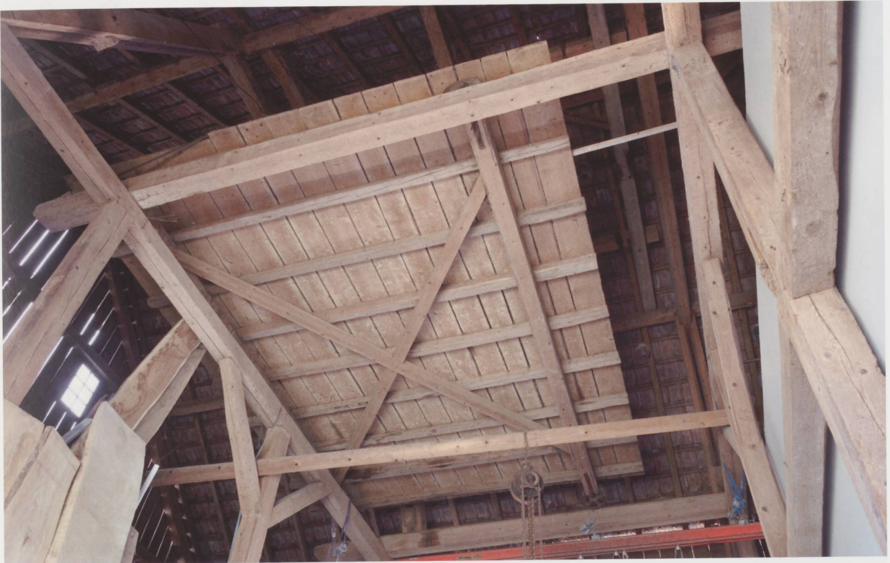
Le pont roulant de la grange a été conservé.
