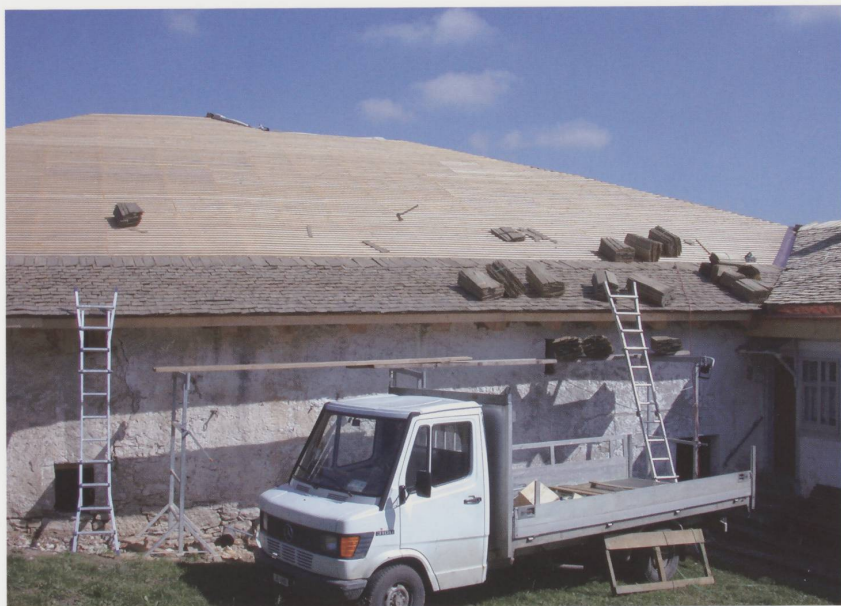
Travaux de couverture en cours – clouage des bardeaux à la main.
