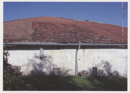
Pan ouest en quatre différentes sortes de tuiles à emboitement et chéneau en tôle zinguée.
