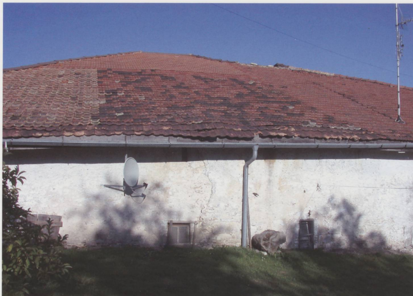
Pan ouest en quatre différentes sortes de tuiles à emboîtement et chéneau en tôle zinguée.
