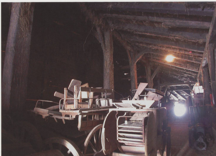
Le pont de grange avant les travaux.
