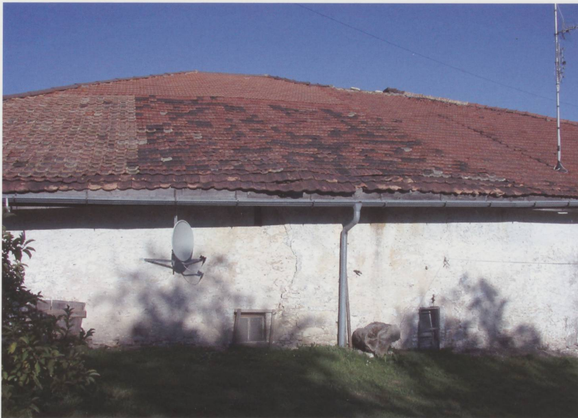
Pan ouest en quatre différentes sortes de tuiles à emboîtement et chêneau en tôle zinguée.
