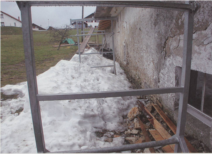
La façade ouest pendant les travaux d'assainissement.
