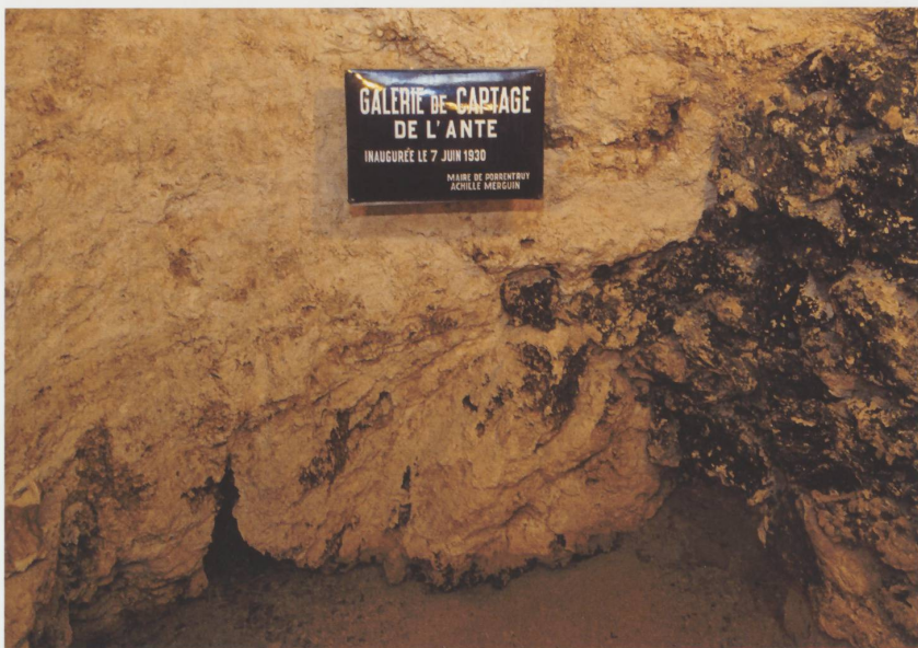
Source de l'Ante. En 1930, des travaux sont entrepris pour optimiser le volume d'eau captée. Il s'agit principalement de la réalisation d'une galerie de 55 m de long entre le captage de la source et la chambre de distribution.
