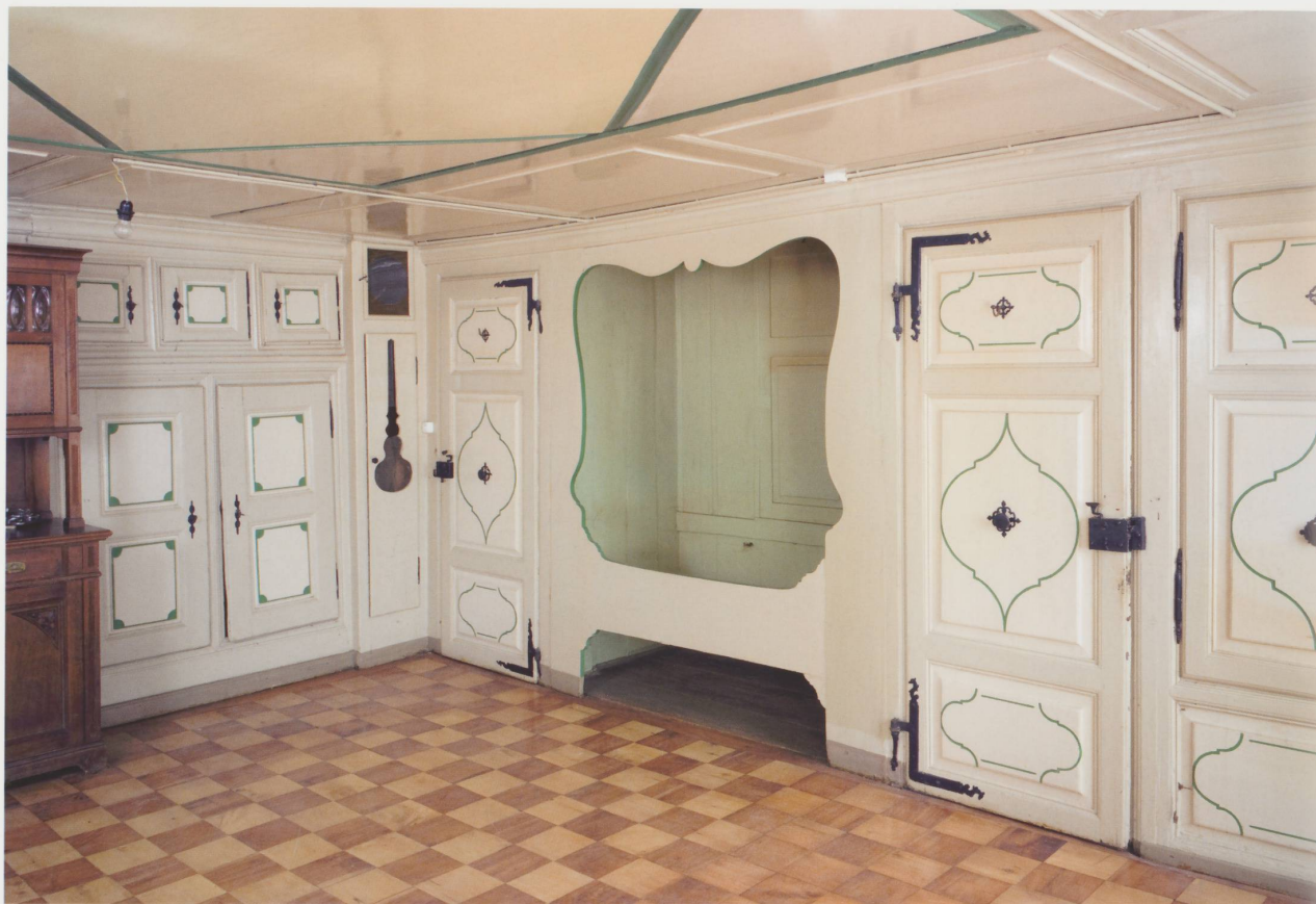
Parois nord et est avec l'alcôve encastrée dans le mur. Cette disposition assez courante dans les fermes du Haut-Plateau visait à conserver un maximum de chaleur. Les nuits d'hiver franc-montagnard sont froides !
