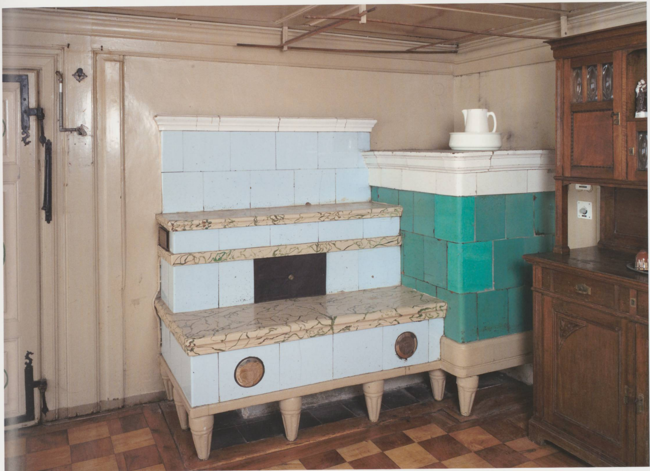
Paroi ouest. Deux poêles d'époques différentes, celui à catelles vertes étant le plus ancien. Remarquez les ferrures et les gonds soutenant la porte, typiques également du XVIII e siècle.
