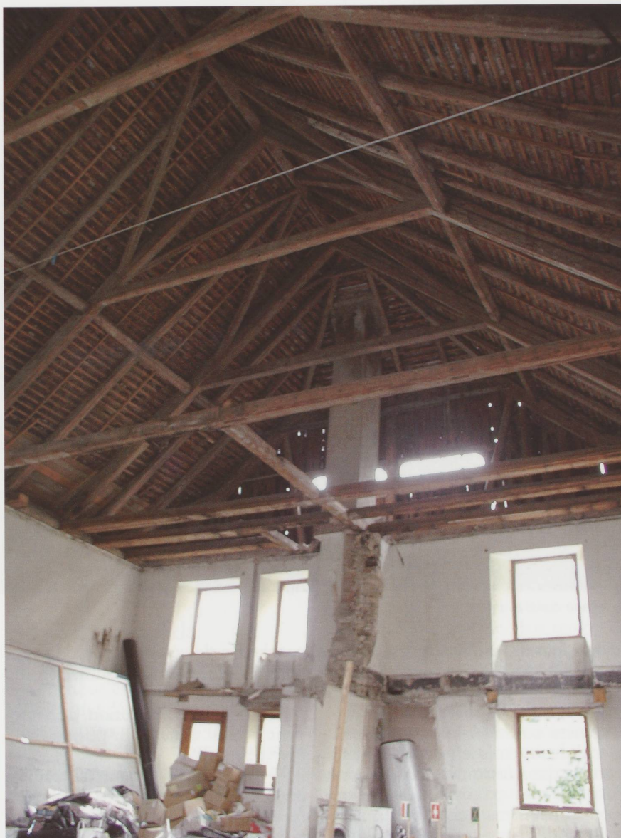
La charpente suspendue en attendant la rénovation des murs (photo: Luc Bron).
