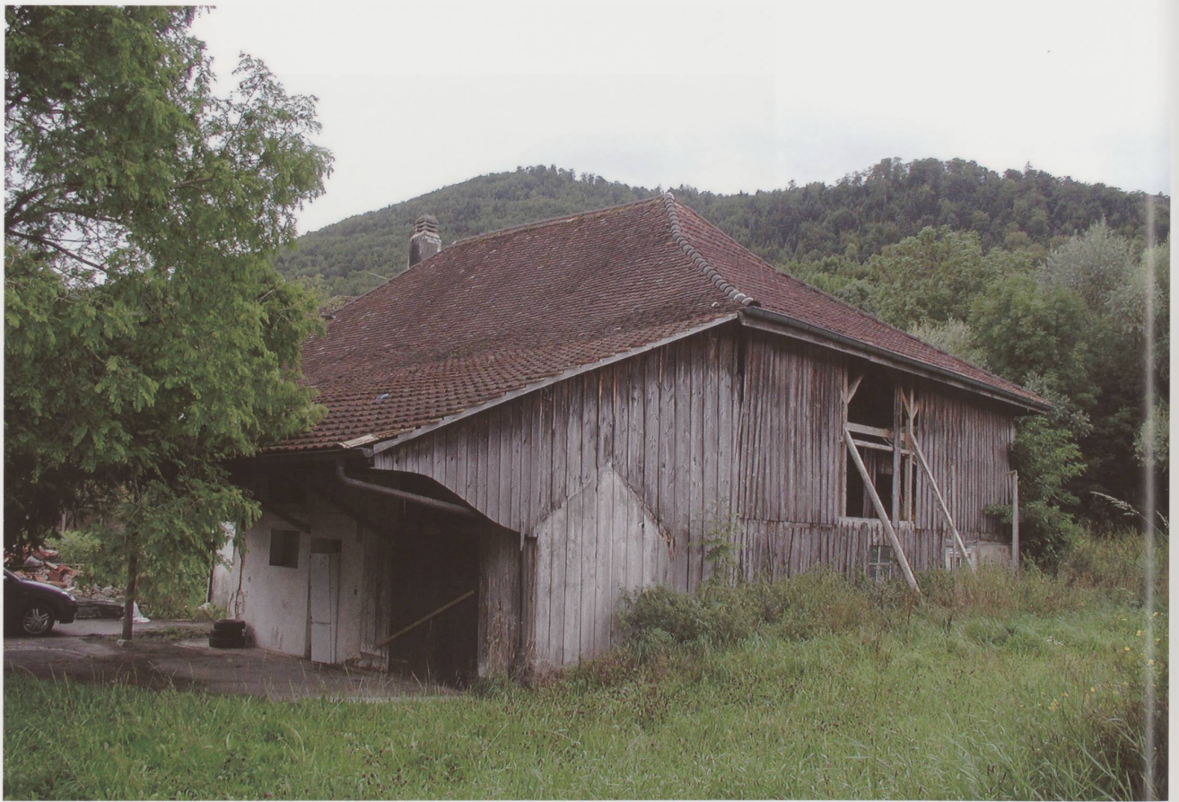
La façade ouest avant...
