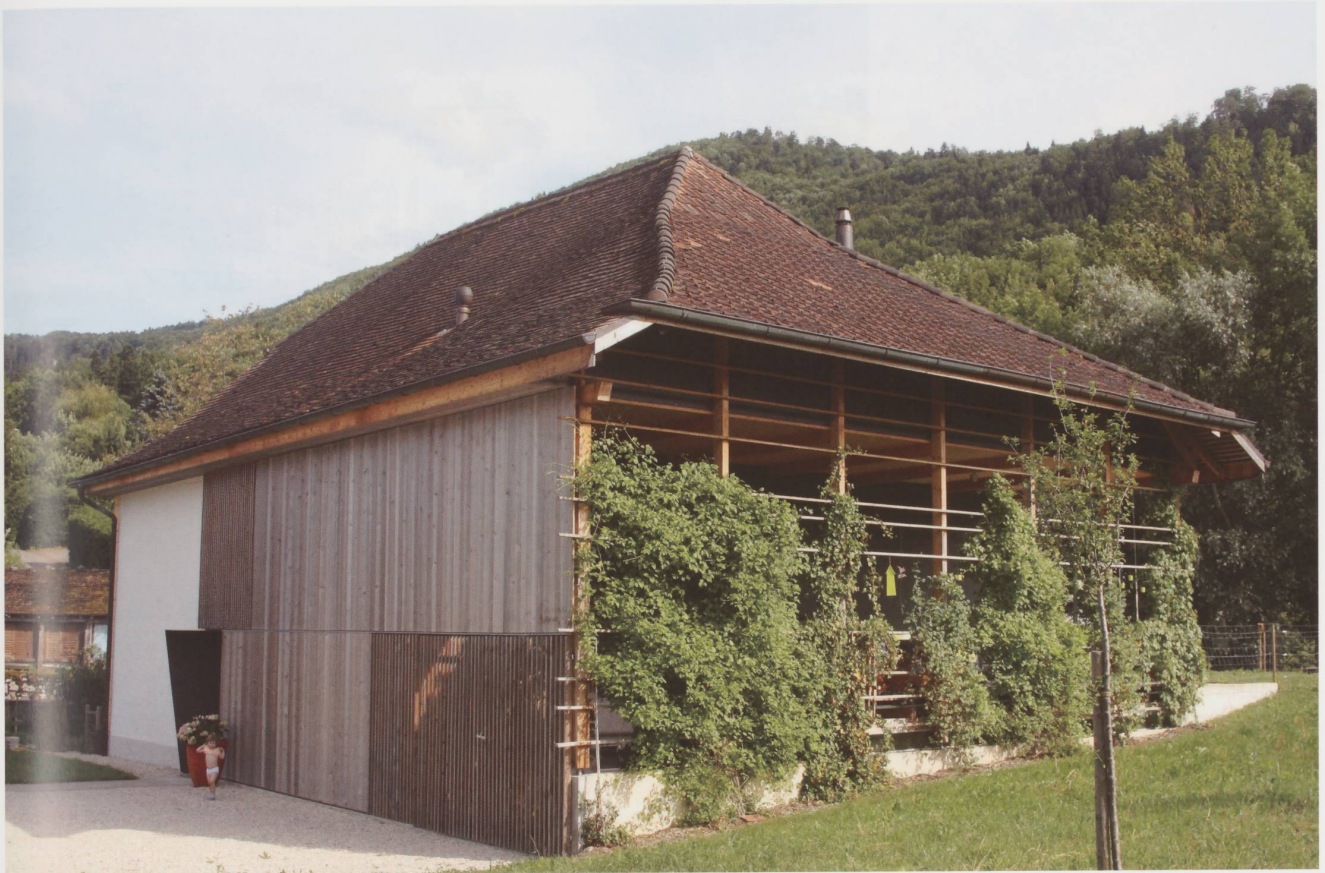
... et après rénovation (photos: Luc Bron).
