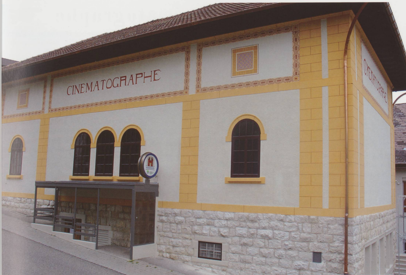
Le Cinématographe de Tramelan. Le bâtiment principal n'a pas subi de modification majeure (à part l'entrée du bar à café). Les façades rénovées ont conservé le décor du début du siècle passé (photo : Cinématographe).
