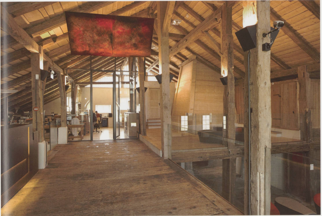
Les planches du pont de grange sont d'origine. Elles masquent une dalle en béton indispensable à une bonne isolation phonique des locaux attenants.
