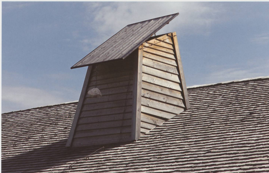
Le « thué » émergeant du toit de bardeaux.
