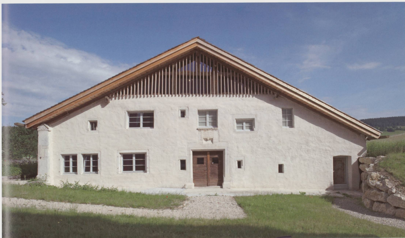
La façade sud.
