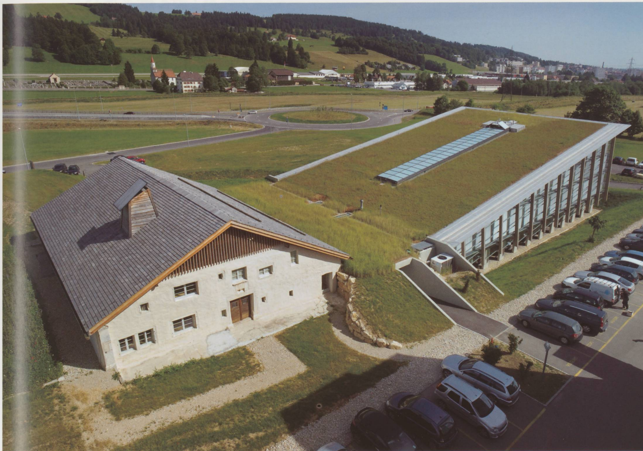
Vue de l'ensemble, prise du toit de l'immeuble voisin.
