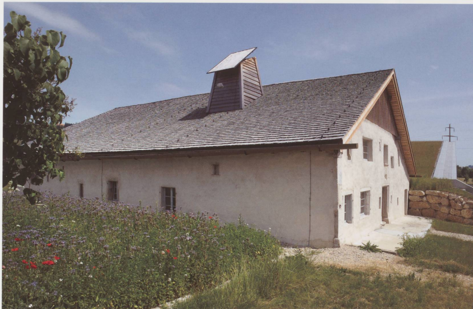
Le toit de bardeaux. Petite entorse à la tradition, les bardeaux ne sont pas en sapin du Jura mais en cèdre rouge du Canada.
