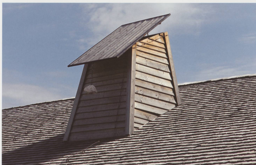
Le « thué » émergeant du toit de bardeaux.
