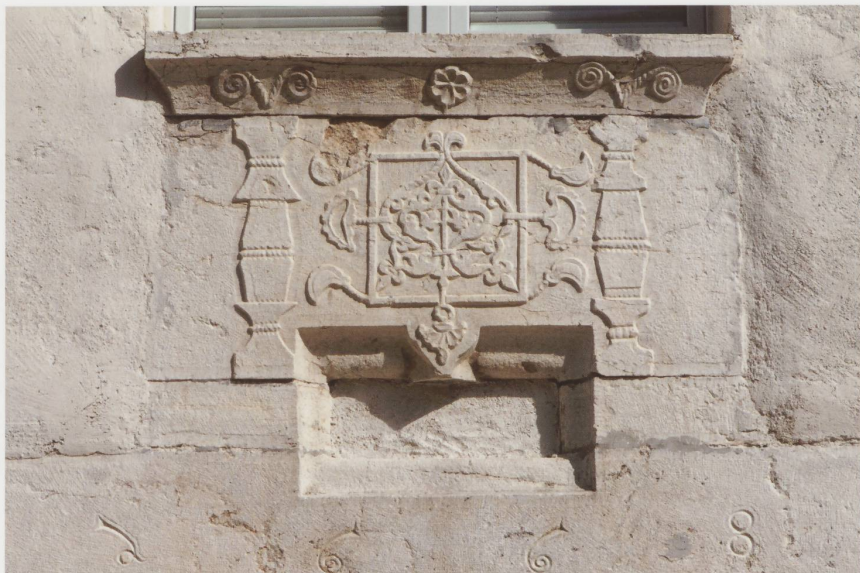
La ferme date du XVII e siècle, comme le montre le beau cartouche de la façade sud.
