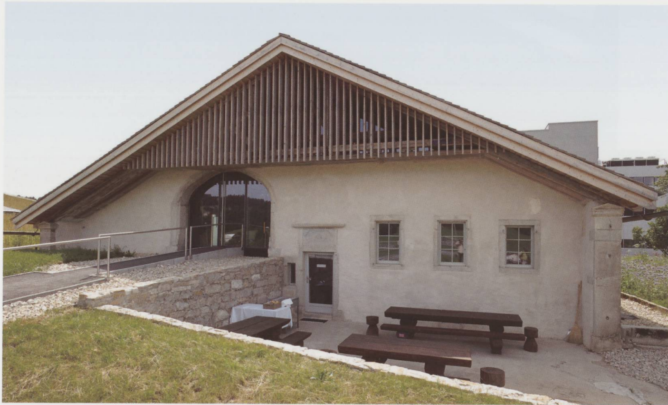
La façade nord de la ferme. La porte du pont de grange constitue l'entrée officielle de la manufacture. Le bardage du pignon, en mauvais état, a été remplacé par un lattage ajouré perpendiculaire à la façade, permettant un éclairage convenable du volume constituant l'ancienne grange.
