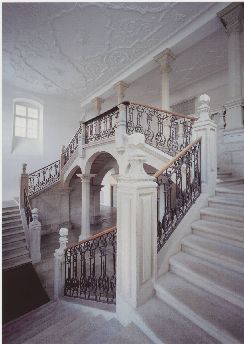
L'escalier monumental de l'entrée nord soutenu par des piliers octogonaux à chapiteaux corinthiens et garni de balustrades en fer forgé. Photo Pierre Montavon
