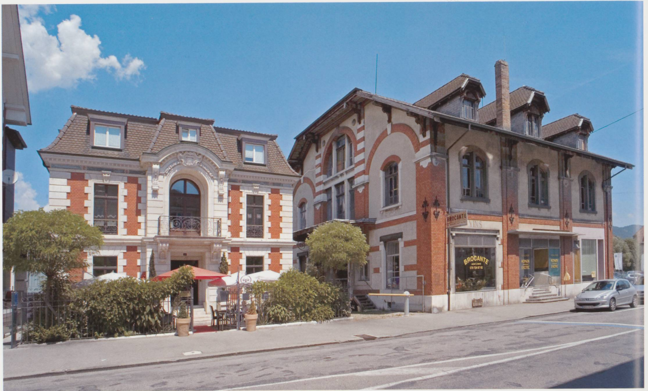
Ill. 2 : Vue de la villa et de l'entrepôt depuis la rue. (Photo Jacques Bélat)
