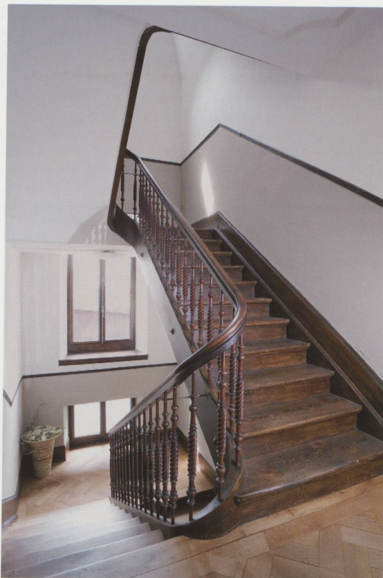
III. 15 : Villa, escalier. (Photo Jacques Bélat)
