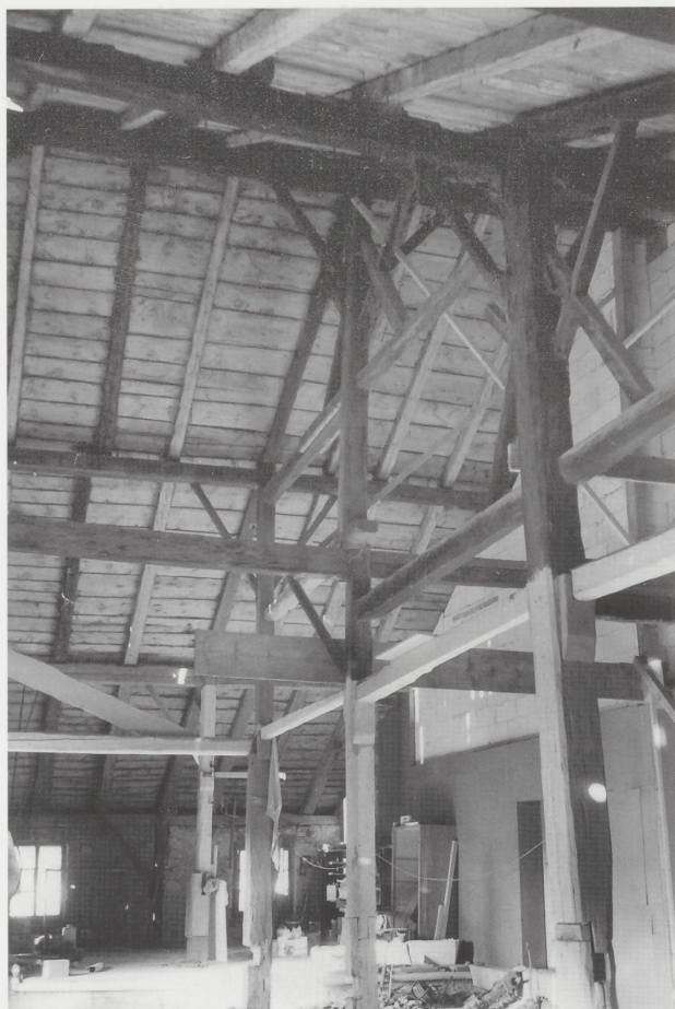
Les travaux de l'an 2000. Un morceau de l'immense espace à construire pour la salle de spectacle, les bureaux. (Photo Gérard Aubry, architecte)
