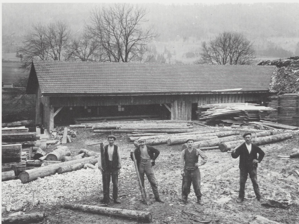
Le chantier de la scierie (vers 1910). Georges Bourquin, propriétaire et scieur, est le deuxième depuis la gauche. (Photo archives hoirie André Bourquin)
