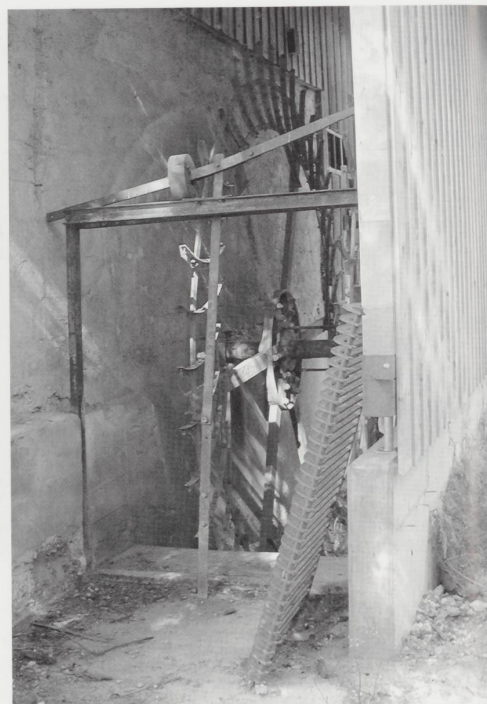
La structure métallique de la roue à aubes en 2005 après les premiers travaux de sauvegarde entrepris par l'Association de la Scierie de Sombeval. (Photo de B. Romy)
