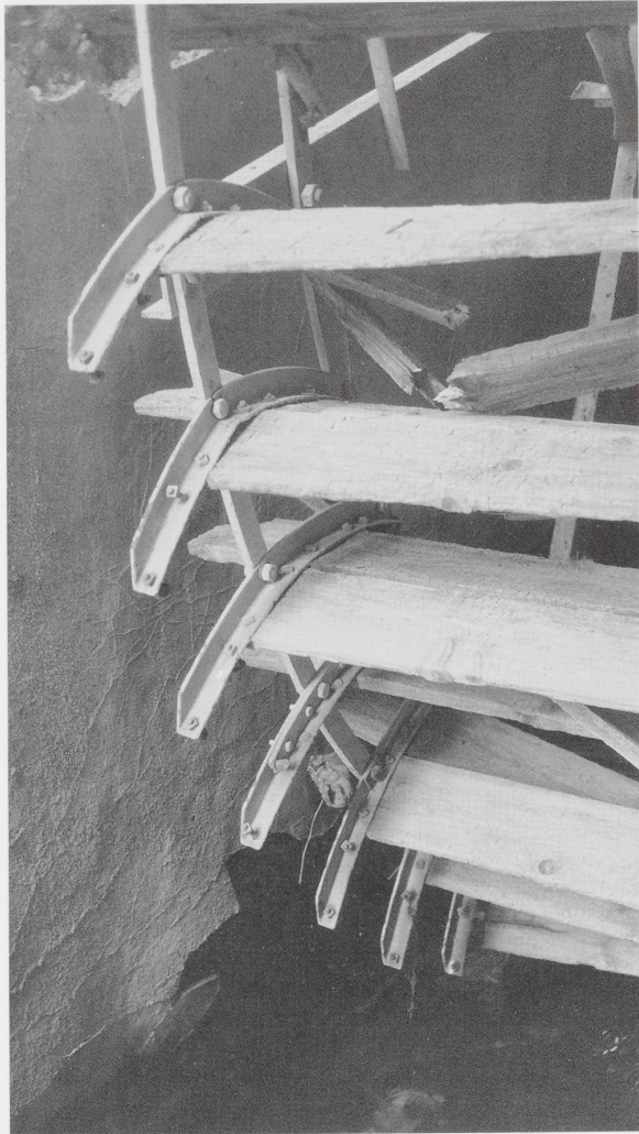
En haut, le train d'engrenages en parfait état de marche lorsque 2 ou 3 « marmelles » ou dents de bois auront été remplacées... - Etat 2005. (Image extraite du film « La Suze, une rivière au parfum d'énergie ».)
