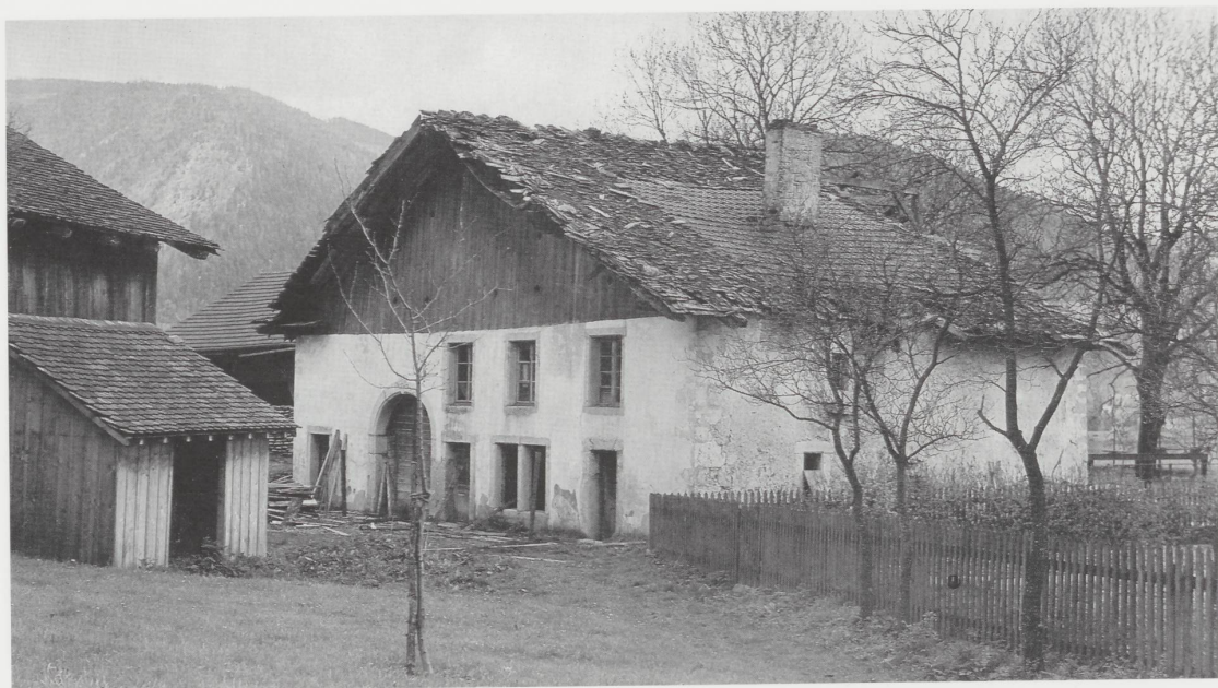
La maison d'habitation comportant grange et écurie attenante au moulin (vers 1910). On distingue les vanes tout à droite du bâtiment et à gauche, dans son prolongement, le toit de la scierie. (Photo archives hoirie André Bourquin)
