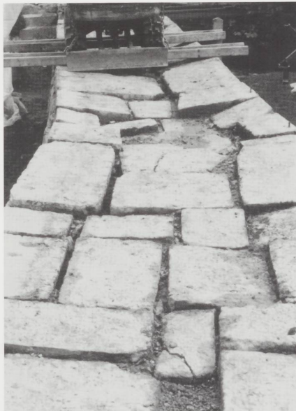
Pendant les travaux de restauration du canal.
