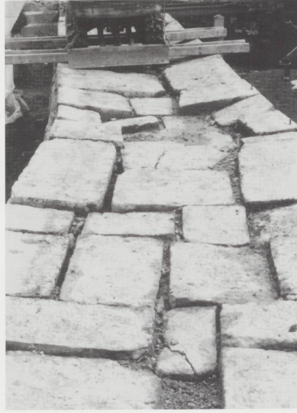
Pendant les travaux de restauration du canal.
