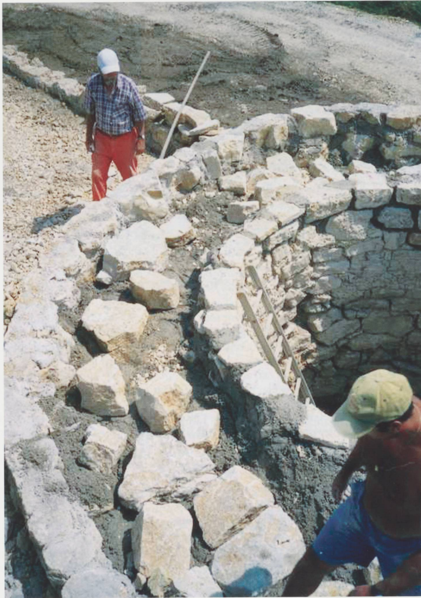
La tour sud-ouest est excavée jusqu'au niveau de terrain. (Photo Jean-Louis Merçay)
