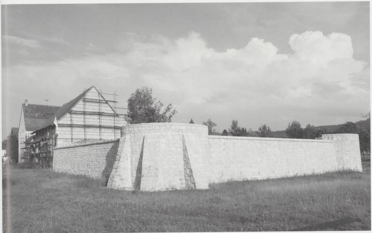
La tour sud-ouest. (Photo Jacques Bélat)
