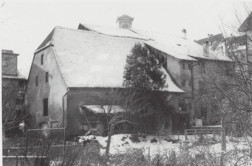
Façade est du bâtiment.
