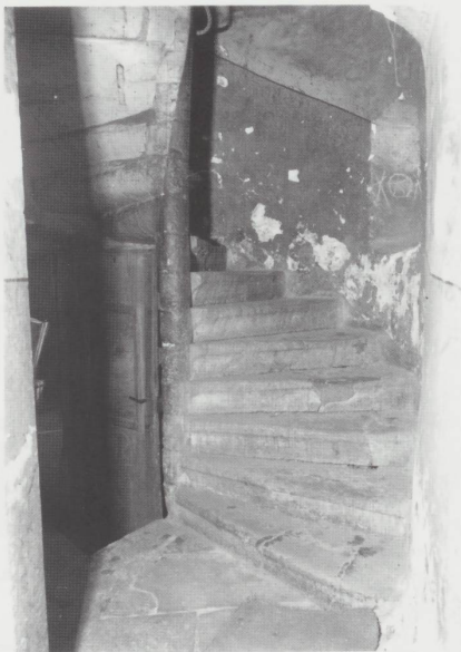
L'escalier à vis dans la tour.
