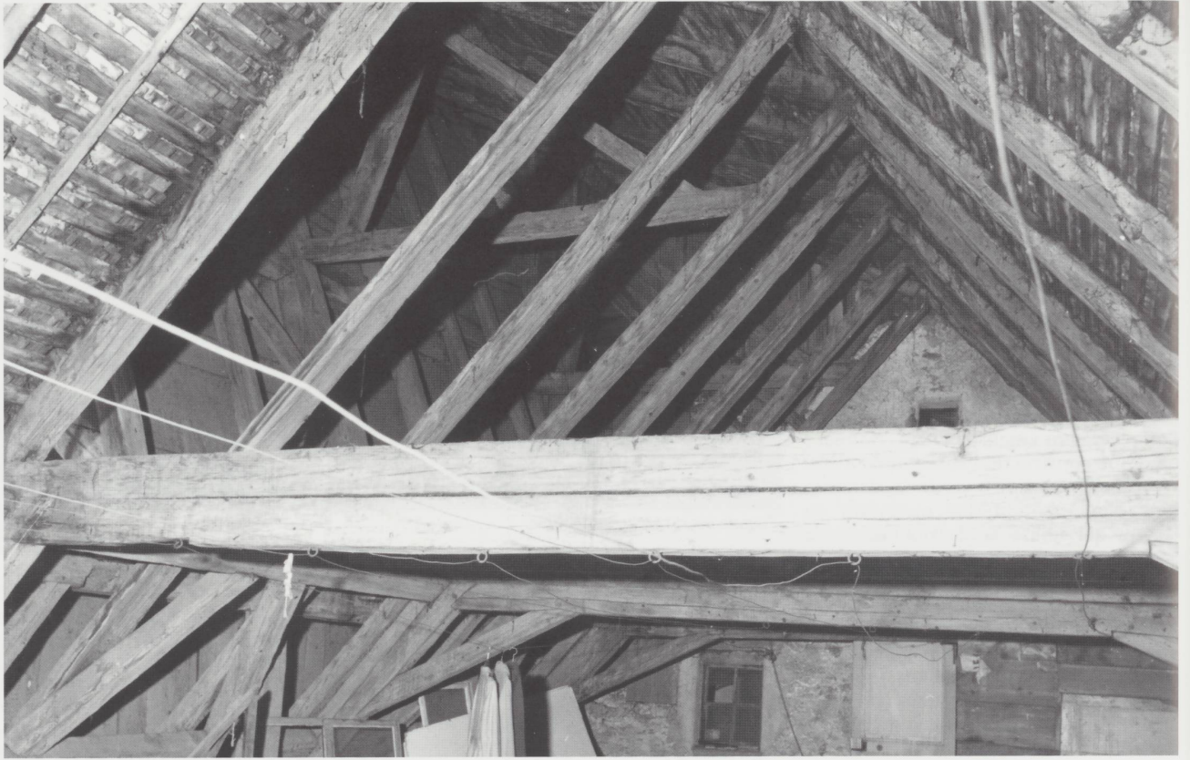
Une partie de la poutraison.
