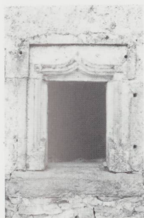
Petite fenêtre de la façade sud
