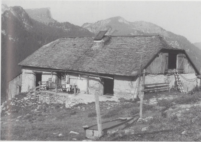
Alpage de la Savolaire – toit de tavillons – commune de Rossinière (VD).
