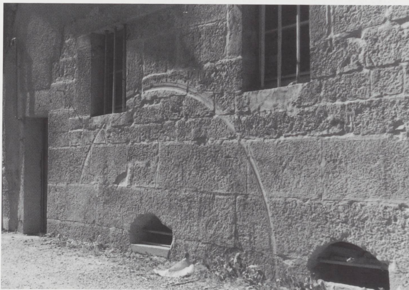
Porrentruy. Marque d'usure due au frottement de la roue du moulin de la ville sur sa façade ouest. Ce bâtiment porte le N° 26 de la rue Pierre-Péquignat. (Photo: collection privée)
