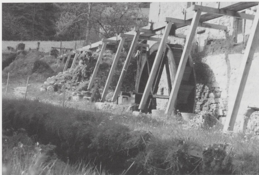
Moulin de Soubey. Le nouveau canal d'amenée d'eau en bois et la nouvelle roue à aubes également en bois, mis en place en 1998. Photo Yves Mahon, 1998
