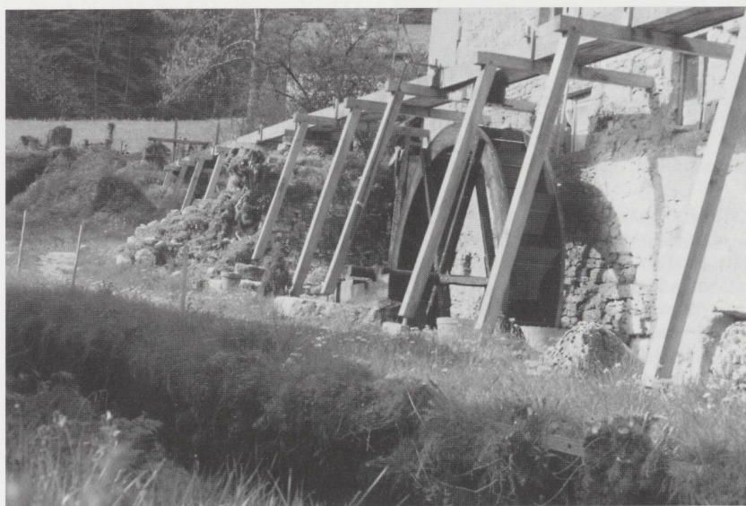
Moulin de Soubey. Le nouveau canal d'amenée d'eau en bois et la nouvelle roue à auges également en bois, mis en place en 1998. Photo Yves Mahon, 1998
