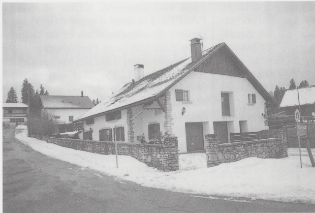
Les Genevez. Ferme du XVII e siècle. Transformation irrespectueuse du passé et du site.
