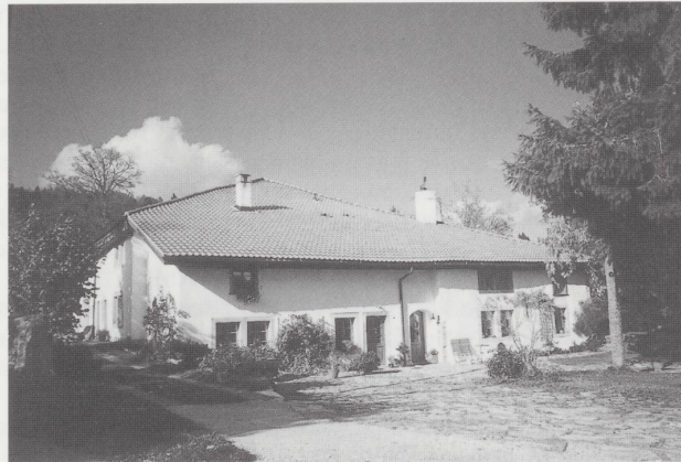
Les Breuleux. Ferme du XVII e siècle. Transformation respectueuse du passé et du site.
