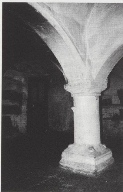
Fahy, bâtiment N° 18. Cuisine voûtée avec pilier central. On distingue en haut à gauche la base du coffre de la grande cheminée de pierre.
