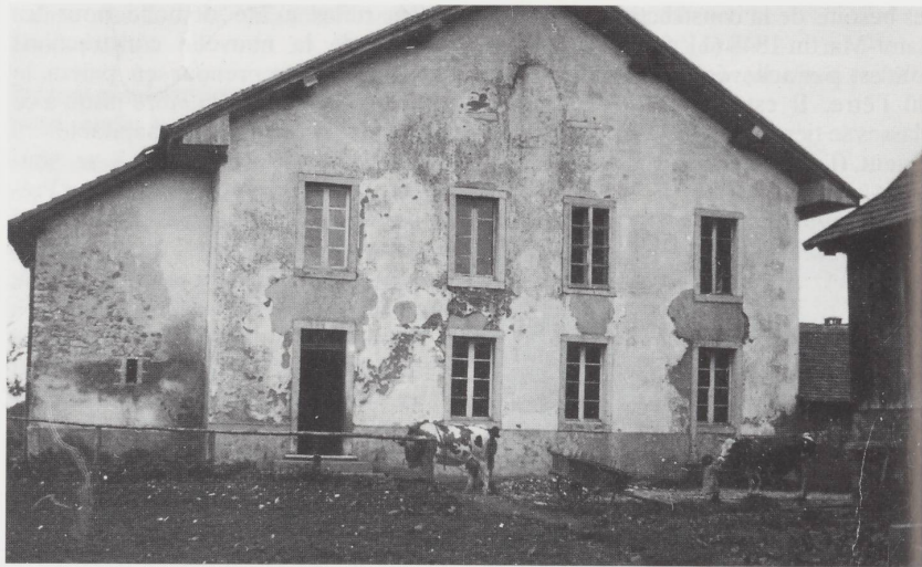
L'ancienne école avant rénovation. (Photo A. Masset, architecte, Delémont, juin 1927)
