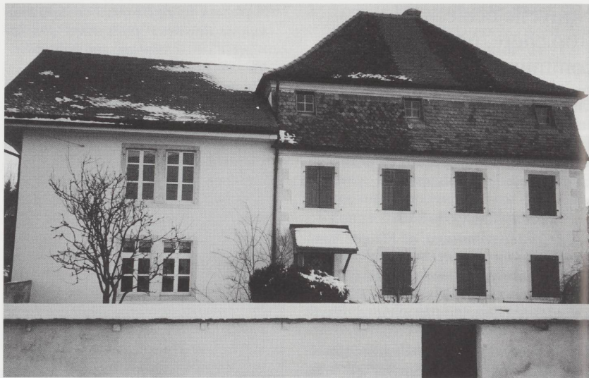
L'école à gauche, construite en 1849, s'appuie sur la cure. (Photo H. Ackermann, 1999)
