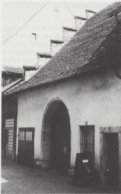
Au N° 9 de la rue des Granges, une ancienne porte de grange. Le mur coupe-feu devait éviter la propagation d'un éventuel incendie. (Photo Jean-Louis Rais, 1999)
