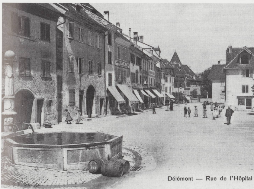
A la rue de l'Hôpital, derrière la fontaine de la Boule, deux portes de granges (début du XX e siècle). (Carte postale, collection du Musée jurassien, Delémont)
