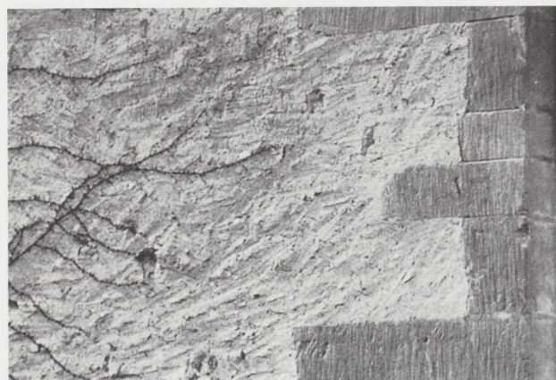
Le crépi s'arrête en mourant sur la chaîne d'angle.
