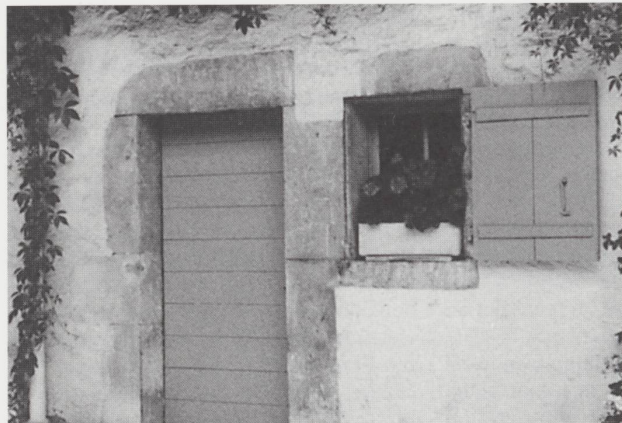
Le crépi épouse les mouvements du mur.
