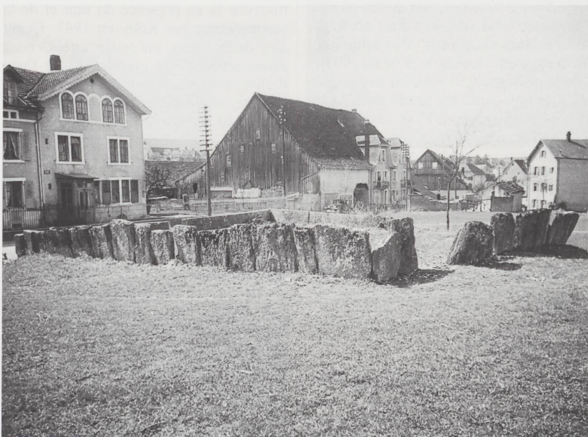
Enclos mégalithique à la route d'Alle à Porrentruy. Photo A. Perronne 4.4.1947 – Démoli le 6.2.1949. Legs Dr A. Perronne – Musée de l'Hôtel-Dieu, Porrentruy.
