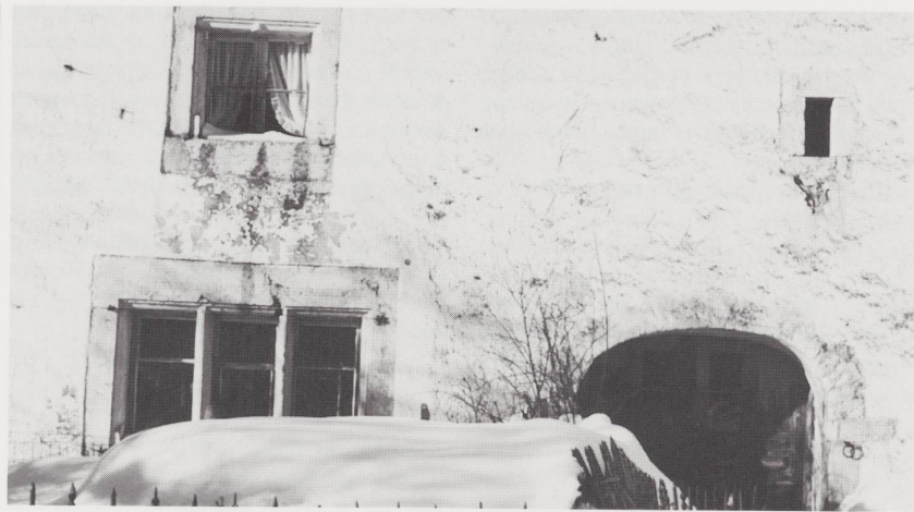
La Bosse. Ferme N° 13, construite en 1684-1685. Son histoire a été liée jusqu'à nos jours à celle de la famille Froidevaux. Cette ferme est certainement, dans ce hameau, celle qui a gardé son cachet le plus pur. La façade sud conserve presque intégralement son aspect du XVII e siècle. La belle chambre possède encore sa splendide fenêtre tripartite pourvue de ses meneaux moulurés à la gothique. L'inscription suivante y est encore lisible: «VINCENT: F. HENRY: F. JEAN: G. F. ADA(M) (.) F. LOUIS: F. FRÈRES. (Photo Bernard Froidevaux)
