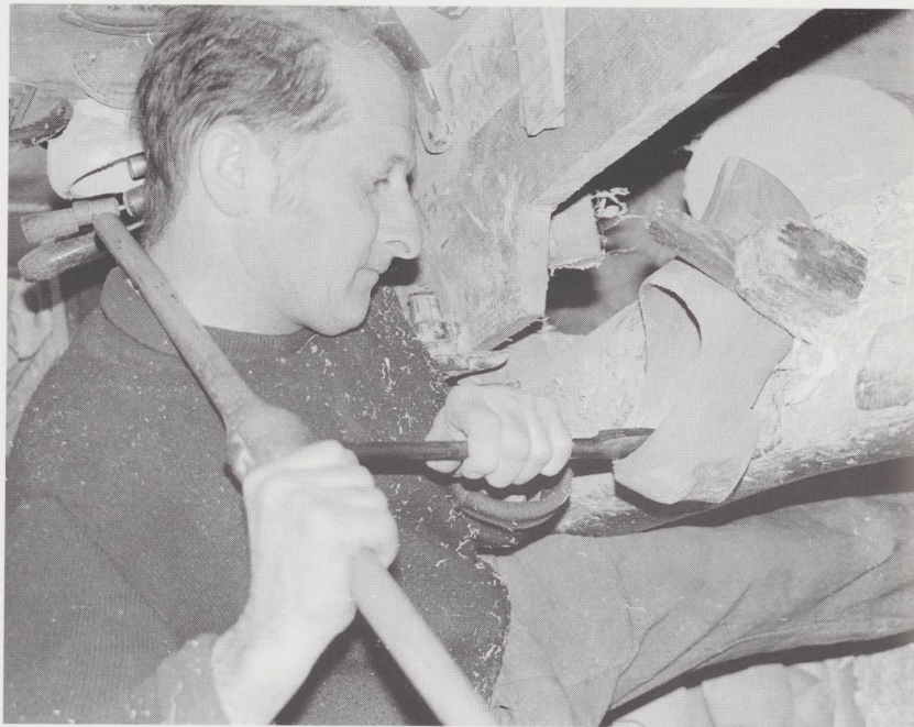
La finition intérieure. Une étape essentielle pour le confort.
