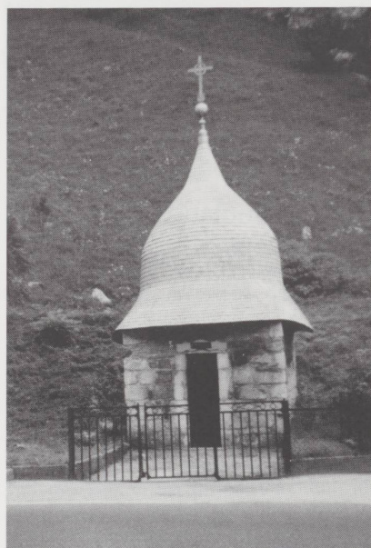
La chapelle Saint-Léger à La Cluse-et-Mijoux, près de Pontarlier, date de 1701. De plan carré, elle est surmontée d'un dôme atypique en bulbe charpenté dit «casque espagnol», recouvert de tavaillons. Un ancêtre!
