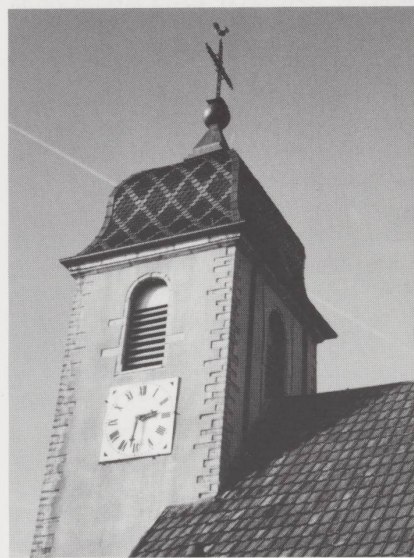
Dôme comtois à tuiles vernissées de l'église paroissiale de Branne (Doubs), surmonté d'un piédouche, d'une boule et d'une croix avec coq de clocher.
